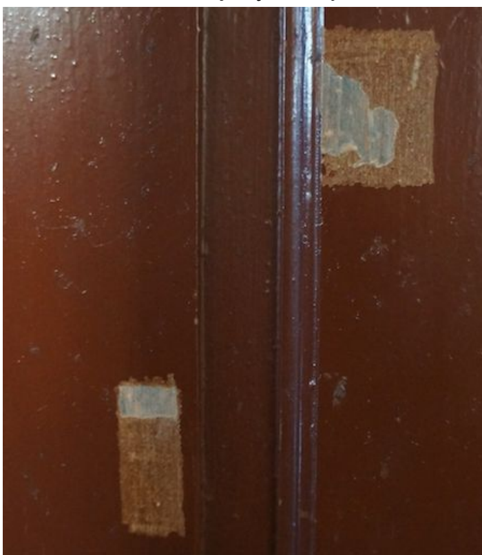
il. 30. Sonda pasowa na drzwiach wejściowych do chóru.
