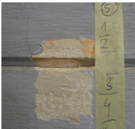
il. 5. Odkrywka pasowa nawarstwień kolorystycznych na północnej ścianie prezbiterium, na boniowaniu.
