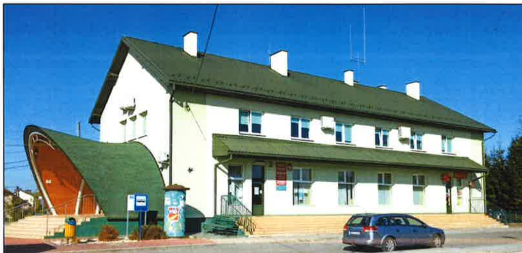
Rys. 7 - Widok elewacji zachodniej
