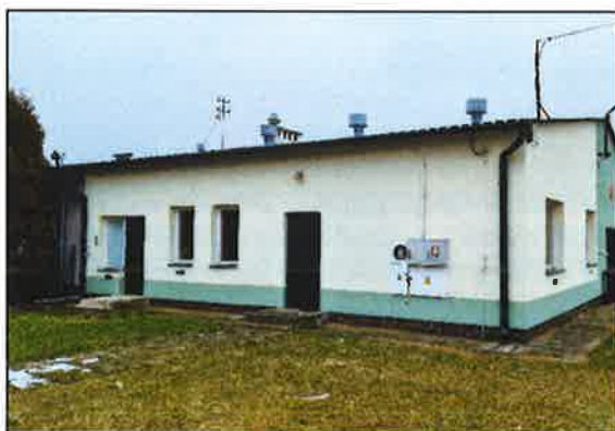
Rys. 13 - Budynek Stacji Uzdatniania Wody
