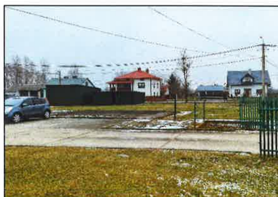
Rys. 14 - Widok terenu Stacji Uzdatniania Wody
