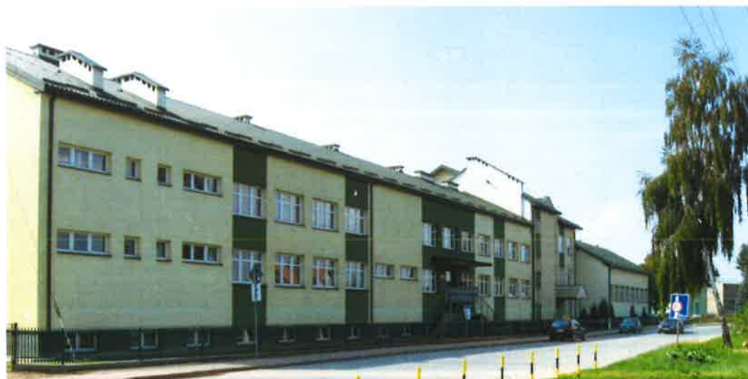
Rys. 10 - Widok elewacji północnej
