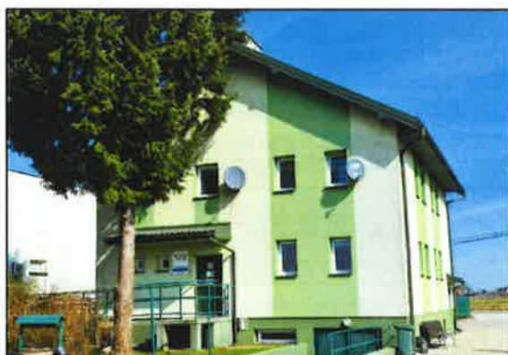
Rys. 16 – Widok ściany południowej
