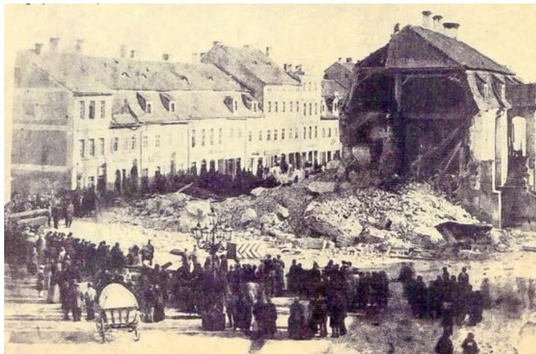
1875: Mieszkańcy Chojnowa zgromadzeni wokół zawalonej wieży ratusza
