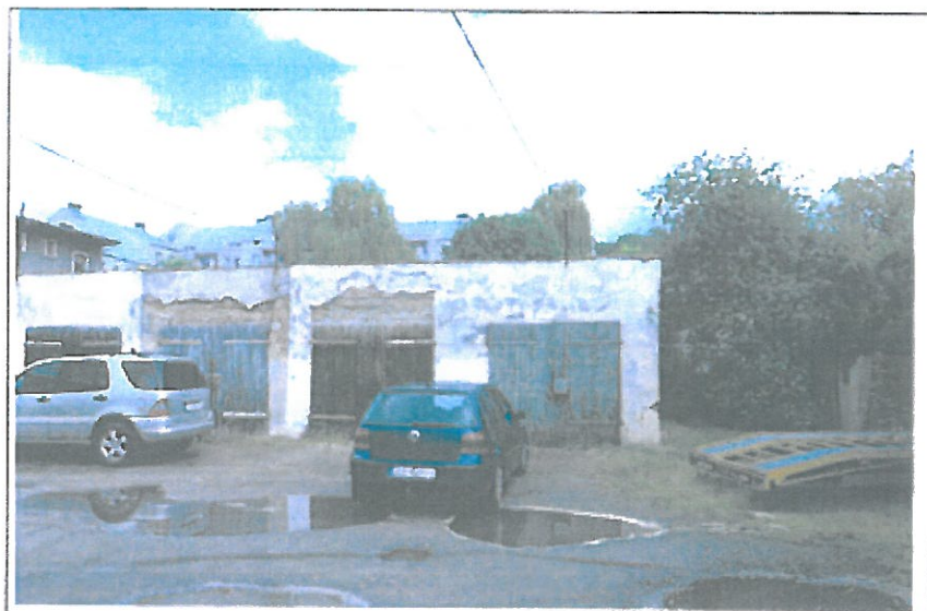
Widok na garaż od południowej strony
