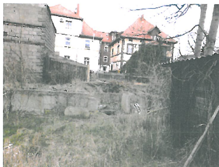
Pozostałości betonowych inspektów i szopa
