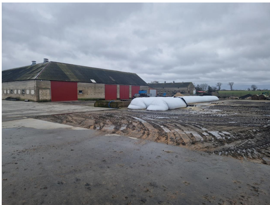
zdjęcie 10. Widok na budynek gospodarczy
