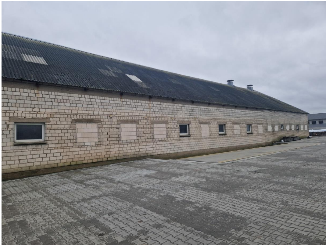
zdjęcie 2. Widok na budynek gospodarczy
