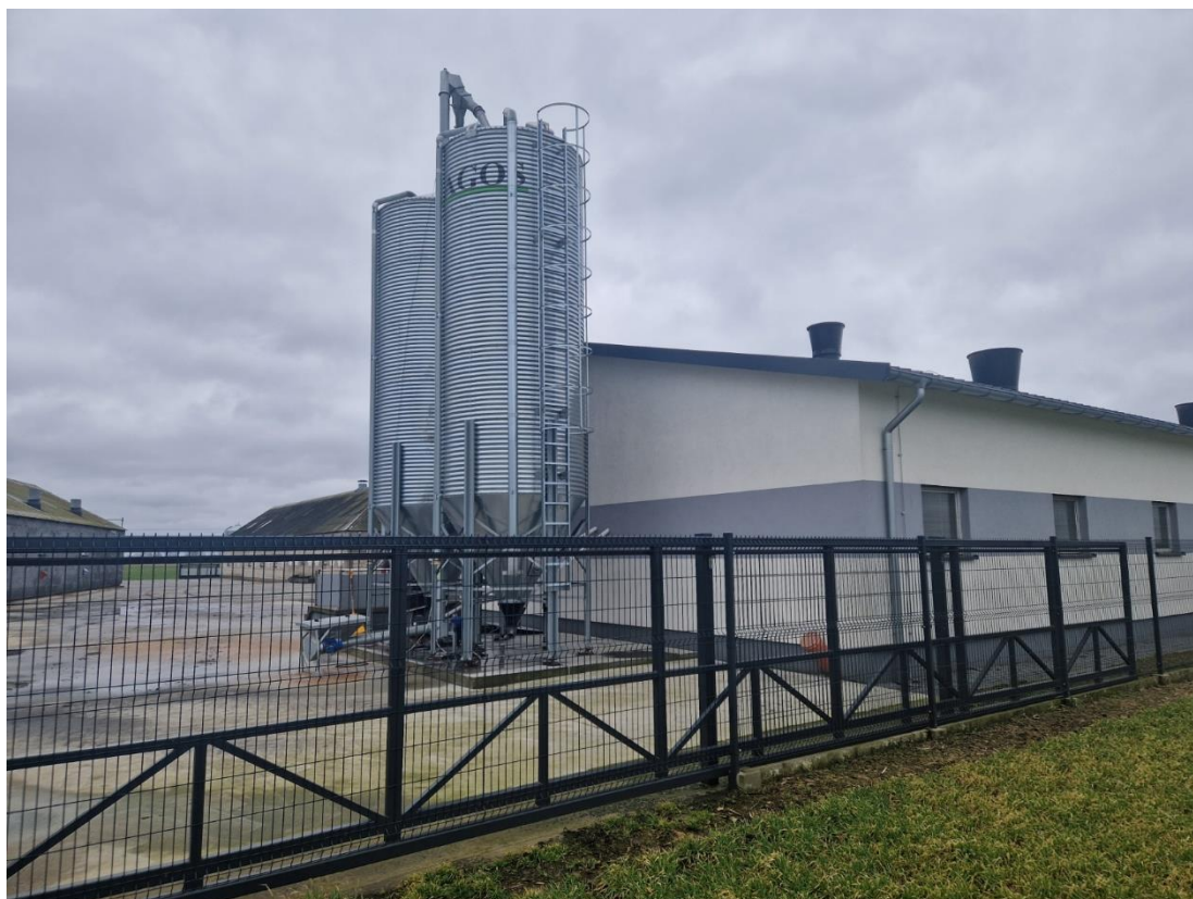
zdjęcie 9. Budynek tuczarni nr 2 oraz silosy na paszę przy budynku
