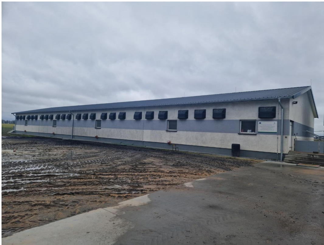
zdjęcie 4. Widok na budynek inwentarski nr 2
