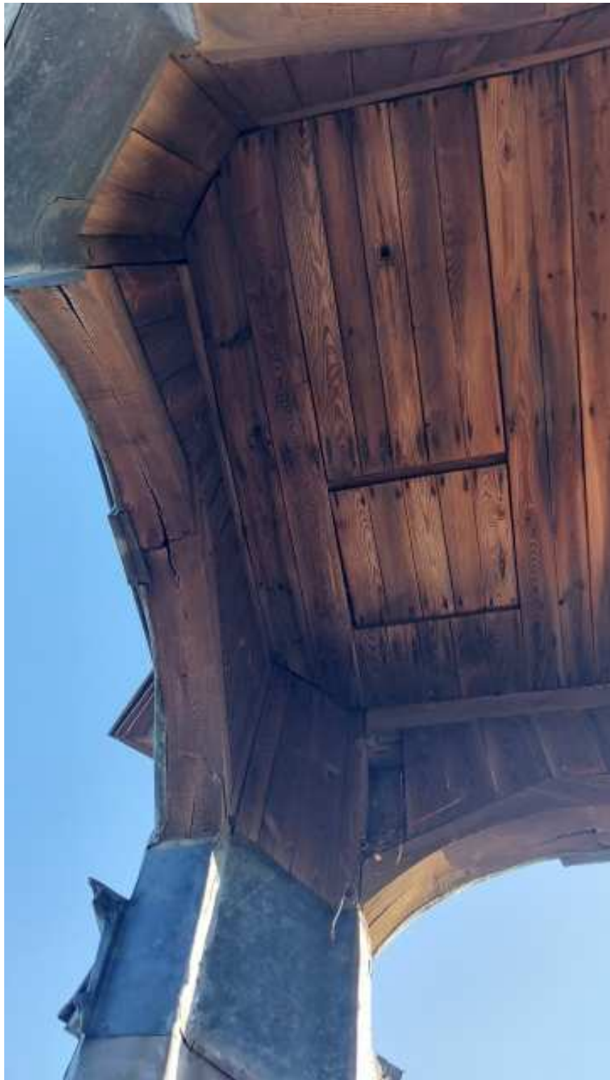
Fot.2 Widok od spodu z poziomu latarni konstrukcji podporowej hełmu wieży. Podwójne słupy obito obwodowo blachą .
