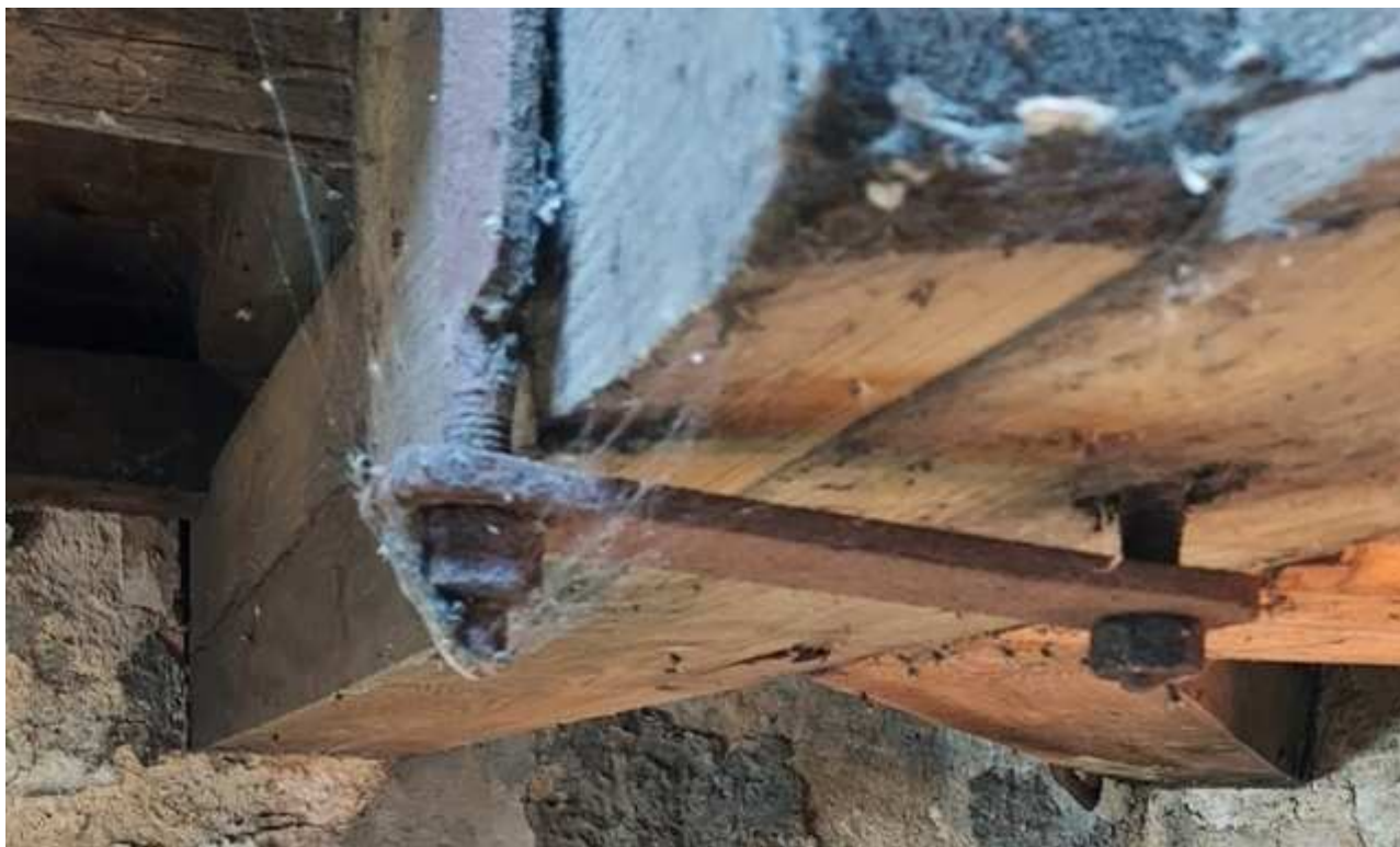
Fot. 7 Niedociągnięte elementy kotwiące słup podporowy hełmu wieży.
