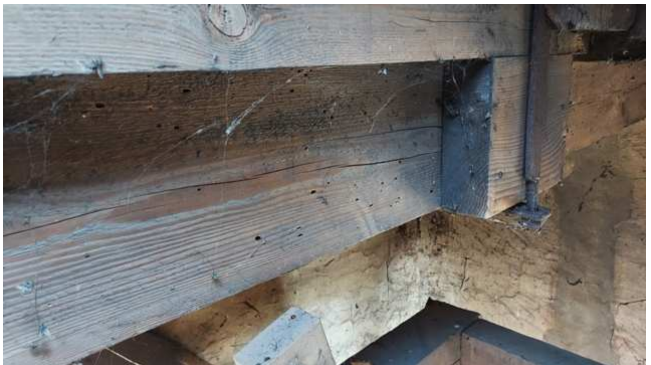
Fot . 4 Widoczne ślady żerowania owadów na powierzchni belki nr 3 (spuszczel).
