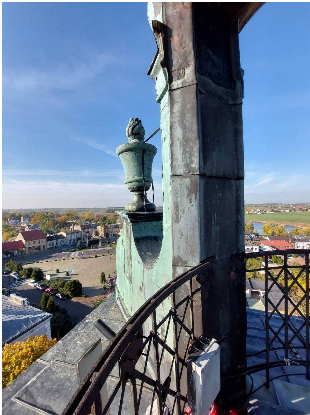
Fot. 4. Widok z poziomu latarni na wieży kościoła pw. św. Jerzego i św. Jadwigi w Klecku - konstrukcja latarni obudowana blachą miedzianą, widoczne elementy dekoracyjne i fragment balustrady.
