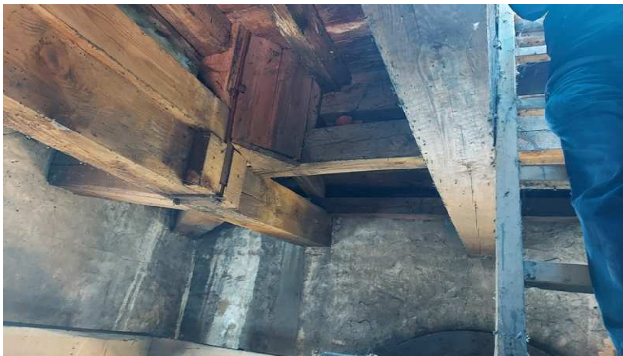
Fot.6 Węzeł narożny rusztu podporowego wieży (belki nr 1 i nr 2). Na deskach pomostu latarni i belce podporowej pomostu widać strzępki grzyba domowego białego (górna, środkowa część zdjęcia).
