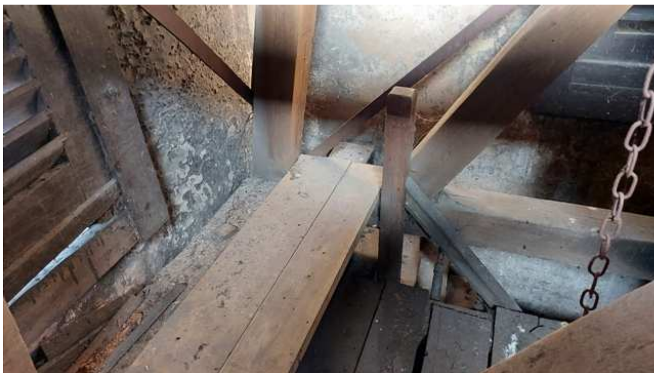
Fot.11 Naroże E konstrukcji wsporczej dzwonu, opartej na podwalinie 24x24 cm.
