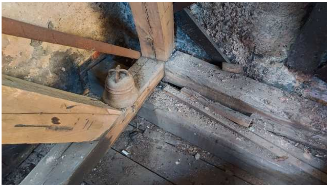
Fot.11 Naroże E konstrukcji wsporczej dzwonu, opartej na podwalinie 24x24 cm.
