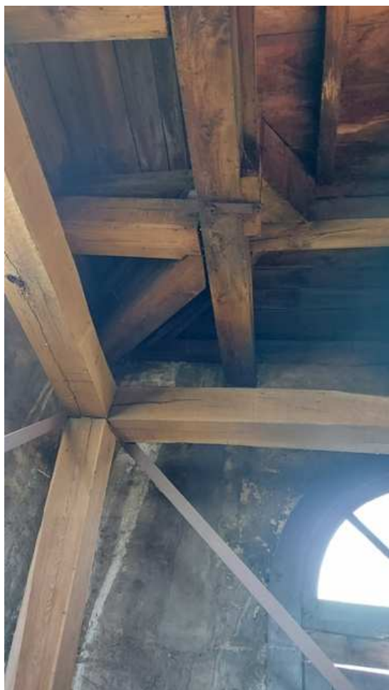
Fot. 7 Niedociągnięte elementy kotwiące słup podporowy hełmu wieży.
