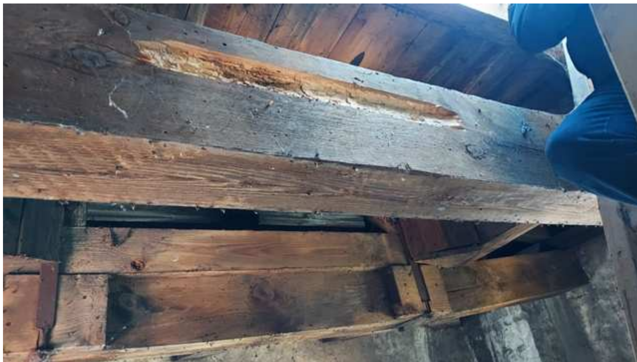
Fot.5 Belka środkowa nr 2 po usunięciu wierzchniej, zniszczonej warstwy drewna (ubytki głębokości do 3 cm)
