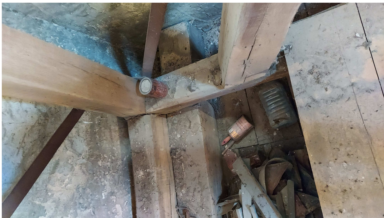
Fot.10 Naroże D konstrukcji wsporczej dzwonu, opartej na podwalinie 24x24 cm.
