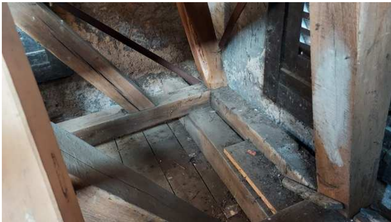
Fot.9 Naroże C konstrukcji wsporczej dzwonu, opartej na podwalinie 24x24 cm.
