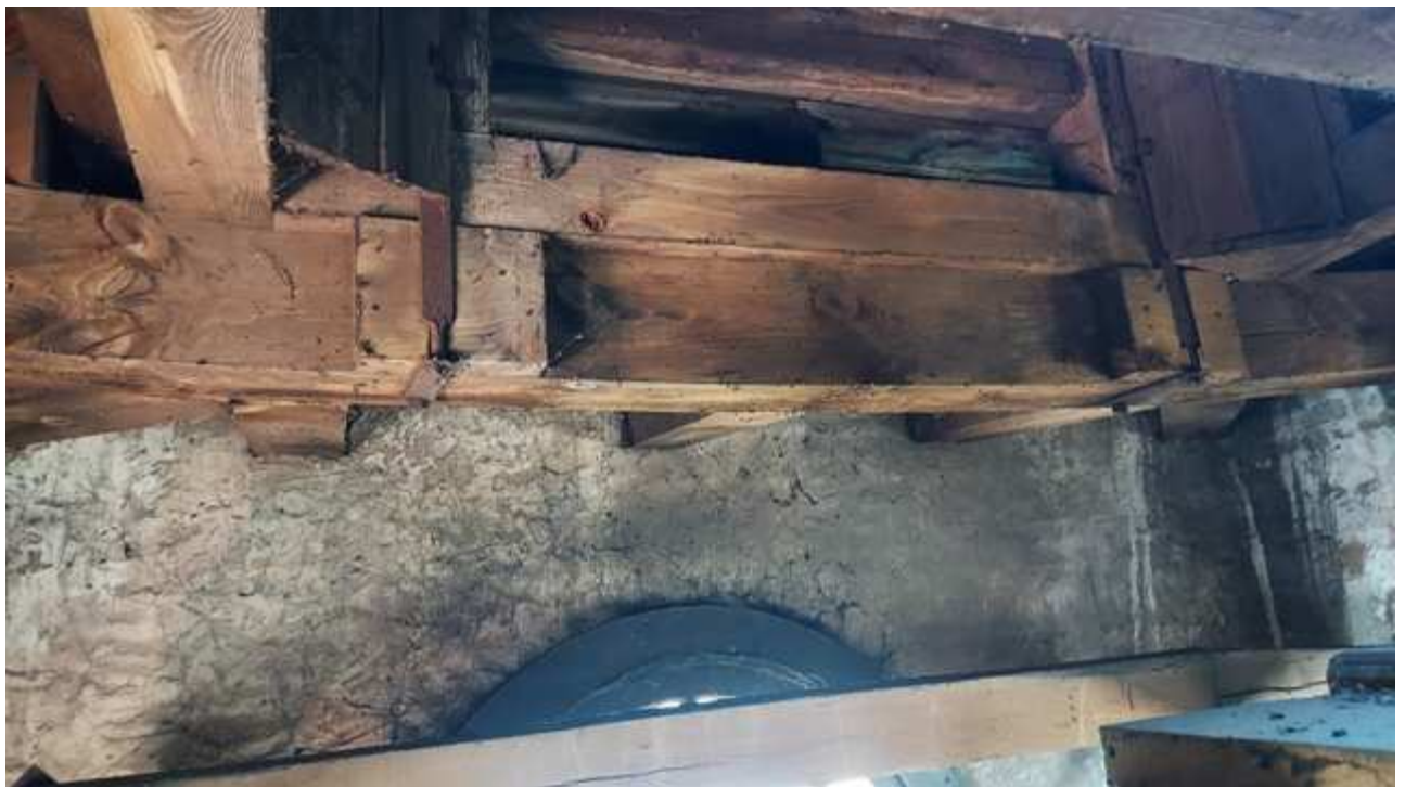
Fot.3 Belka podporowa latarni wieży nr 1 – widoczne znaczące ugięcie elementu. Słupy podporowe wieży skotwiono z belką stalowymi obejmami.
