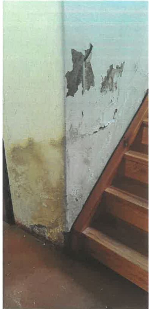
Zawilgocenia strefy cokołowej ścian.
