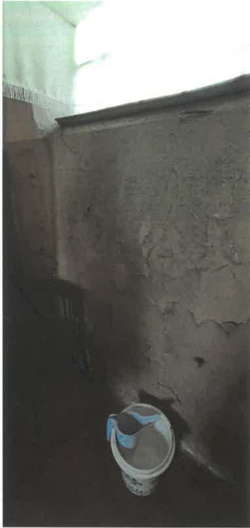
Zawilgocenia strefy cokołowej ścian.
