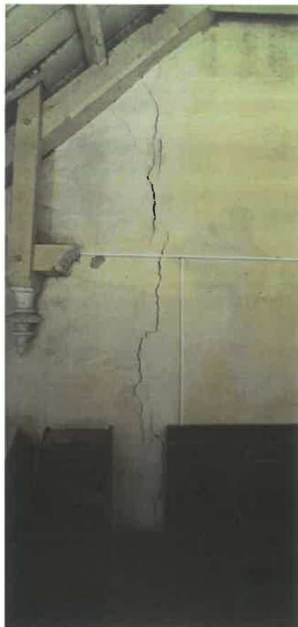
Spękania konstrukcji ściany szczytowej kościoła.
