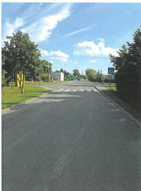
Przejście dla pieszych na ul. Jarzębinowej w Kłecku
