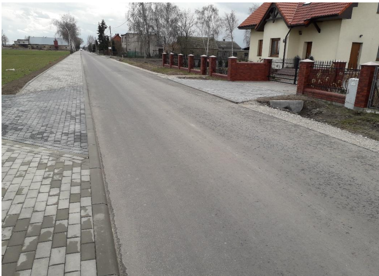
Przebudowany odcinek drogi gminnej nr 283016P we wsi Bojanice
