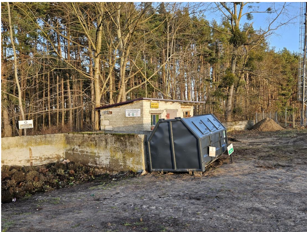
4.7. Odcinek nr 7 – ogrodzenie betonowe – poza zakresem.
