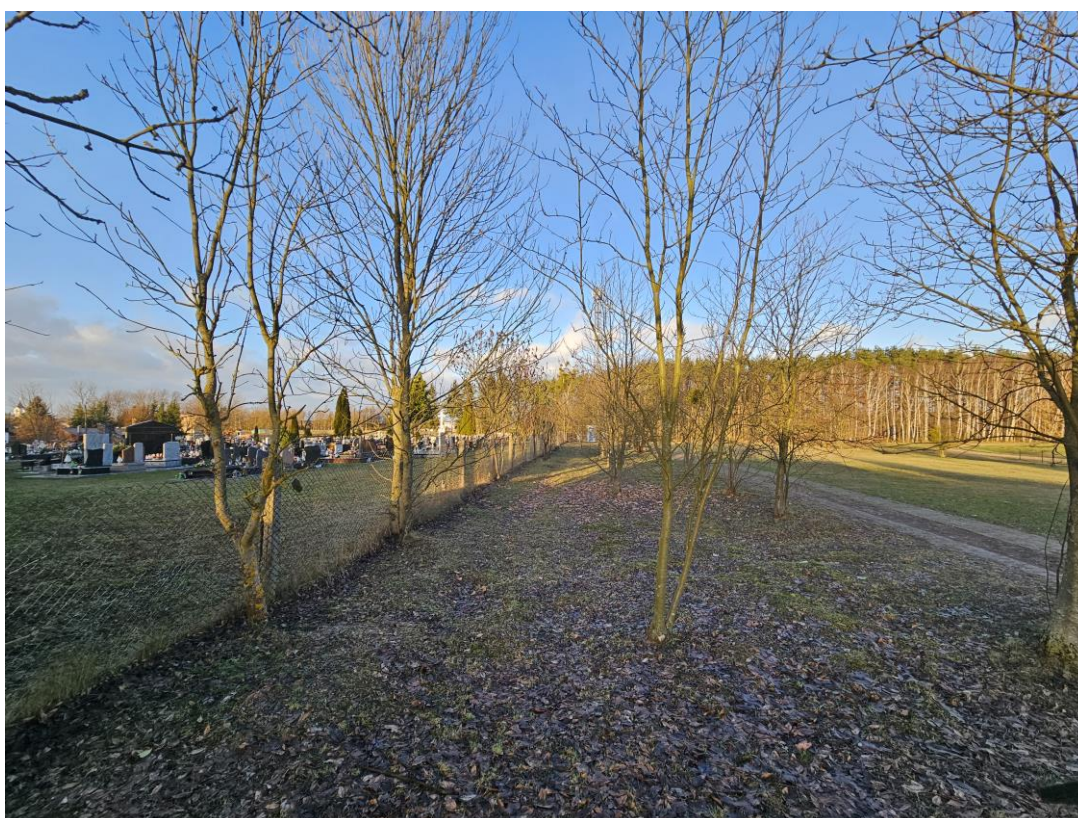
4.8. Odcinek nr 8 – ogrodzenie z siatki na słupkach betonowych.
