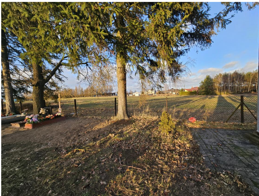
4.6. Odcinek nr 6 – ogrodzenie z siatki na słupkach betonowych.
