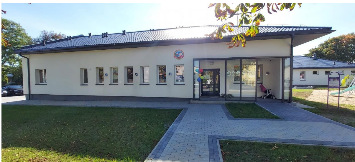
Fotografia przedstawia budynek żłobka „Bajkowa Kraina” w Lnianie.
