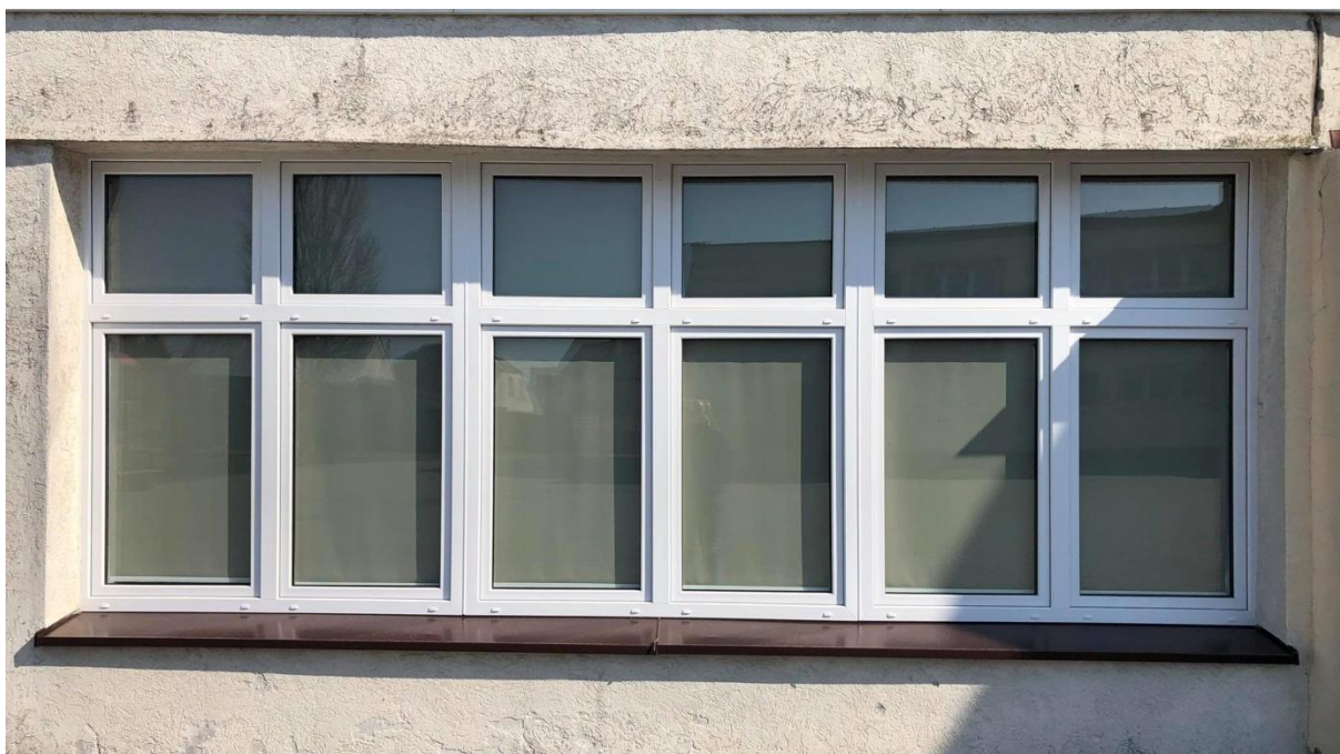
Fotografia przedstawia nowe okna w budynku Szkoły Podstawowej w Lnianie – sala 10.
