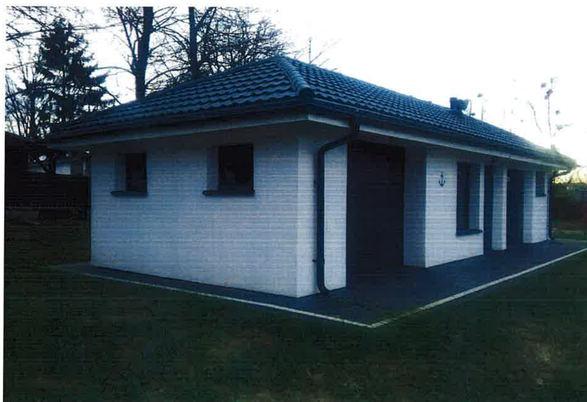
Budynek zaplecza sportów wodnych w Ostrowitem
