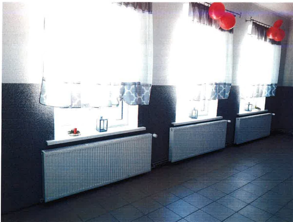
Wykonanie instalacji centralnego ogrzewania w świetlicy wiejskiej w miejscowości Lubodzież
