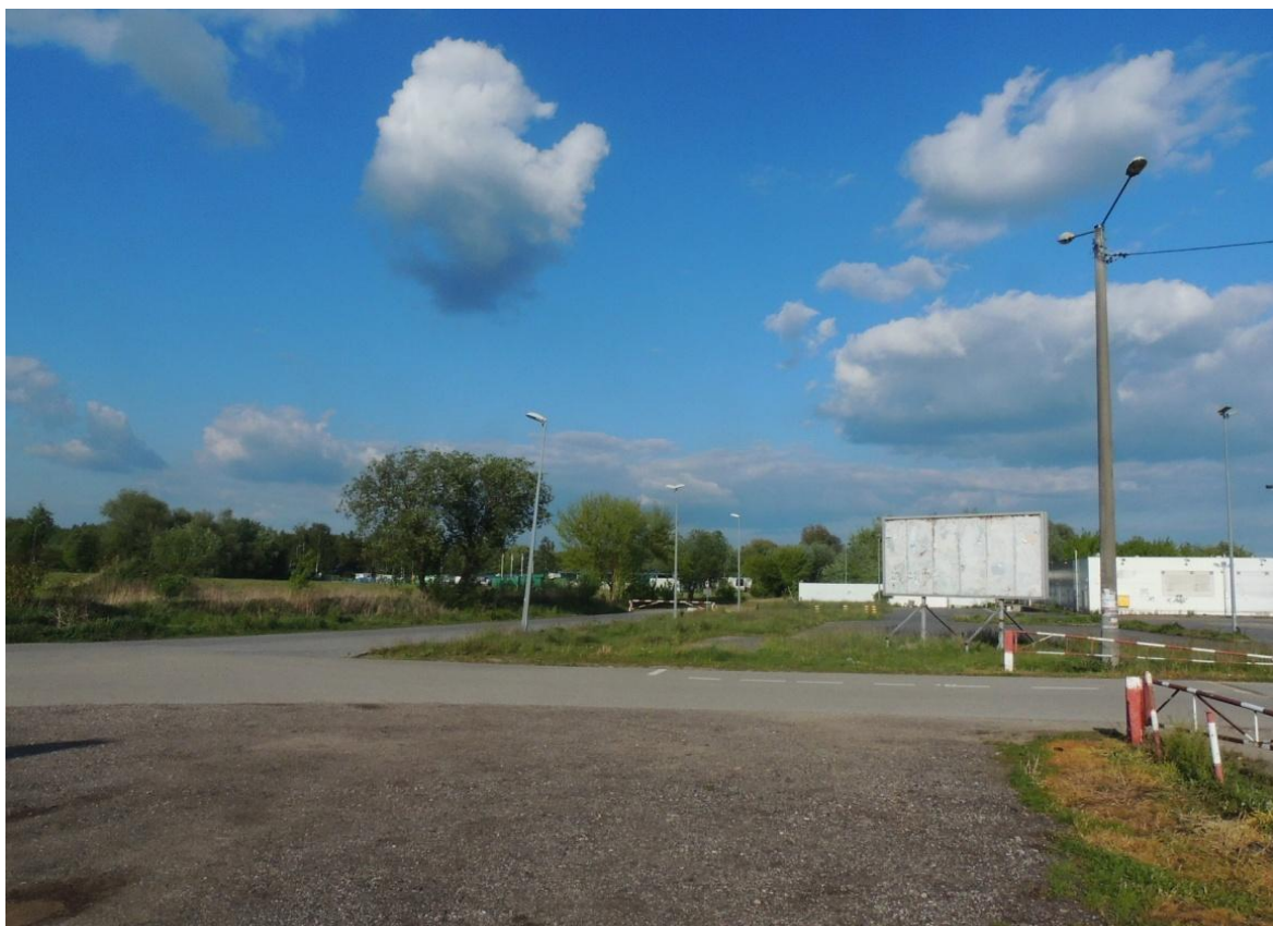
Zdjęcie 6 Droga wojewódzka nr 722 biegnąca w buforze inwestycji.
