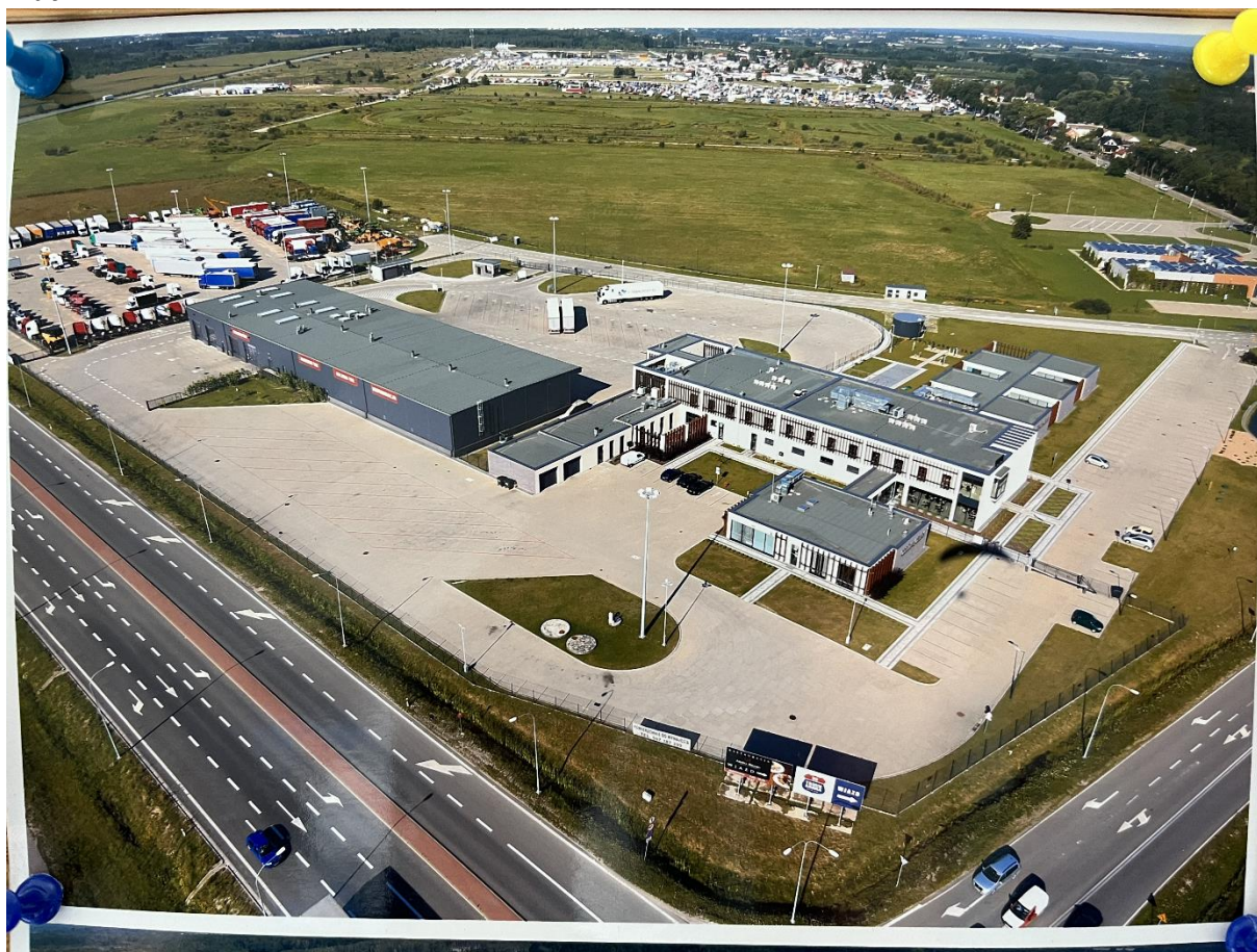
Zdjęcie nr 3. Rzut w kierunku wschodnim.
