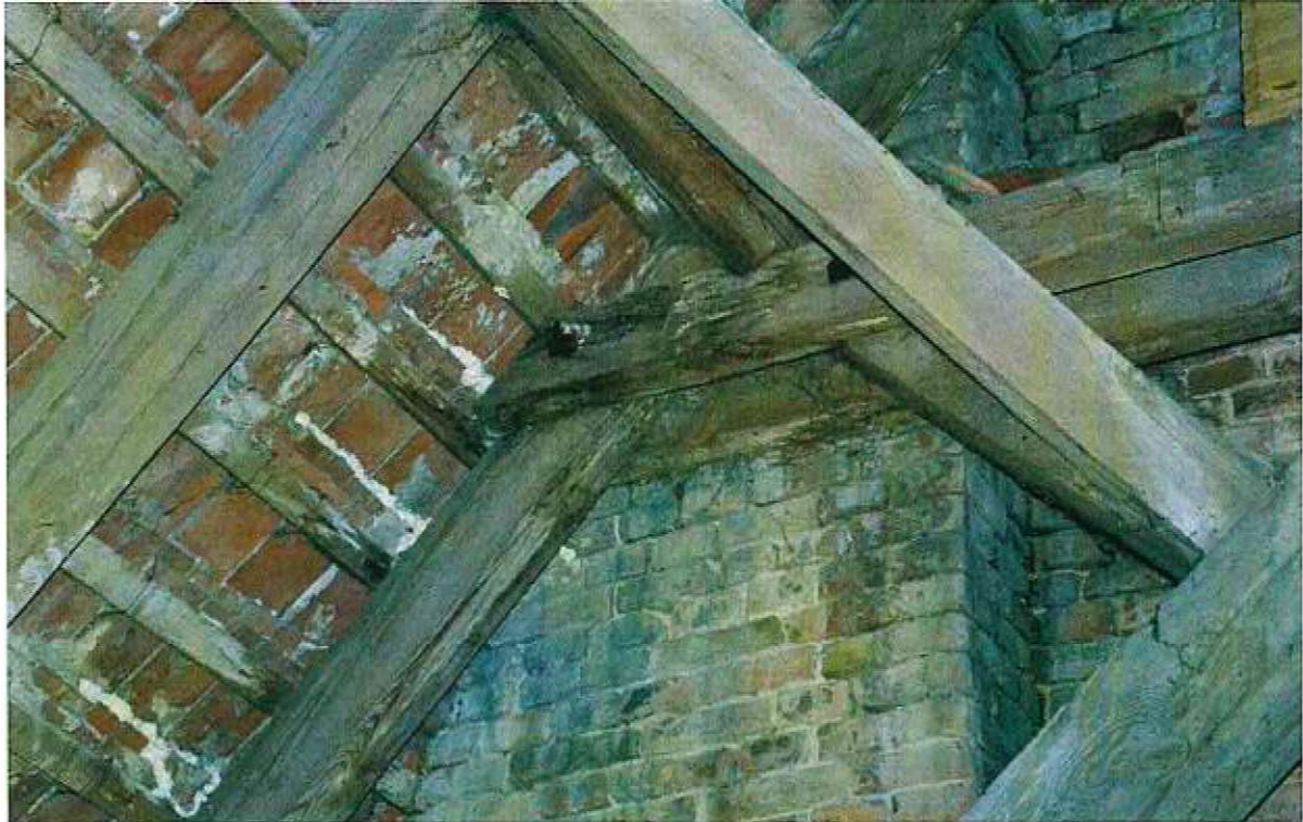
23. Uszkodzenie ściągów górnych przy chórze.
