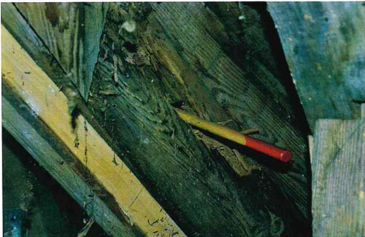
16. Uszkodzenie krokwi koszowej.
