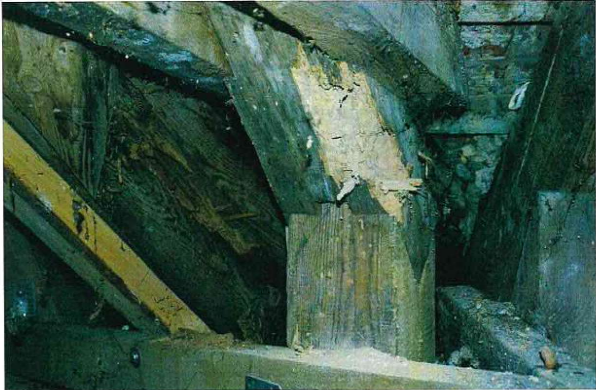
17. Uszkodzenie słupka pod krokwią koszową.
