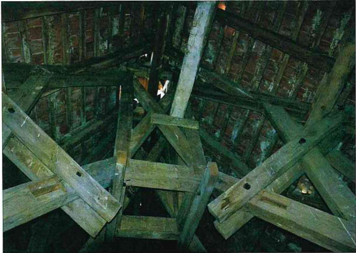
15. Konstrukcja więźby pod sygnaturką.
