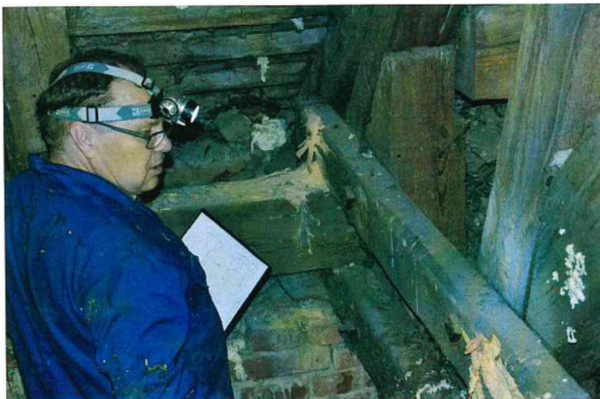
22. Uszkodzenie ściągów dolnych przy chórze.
