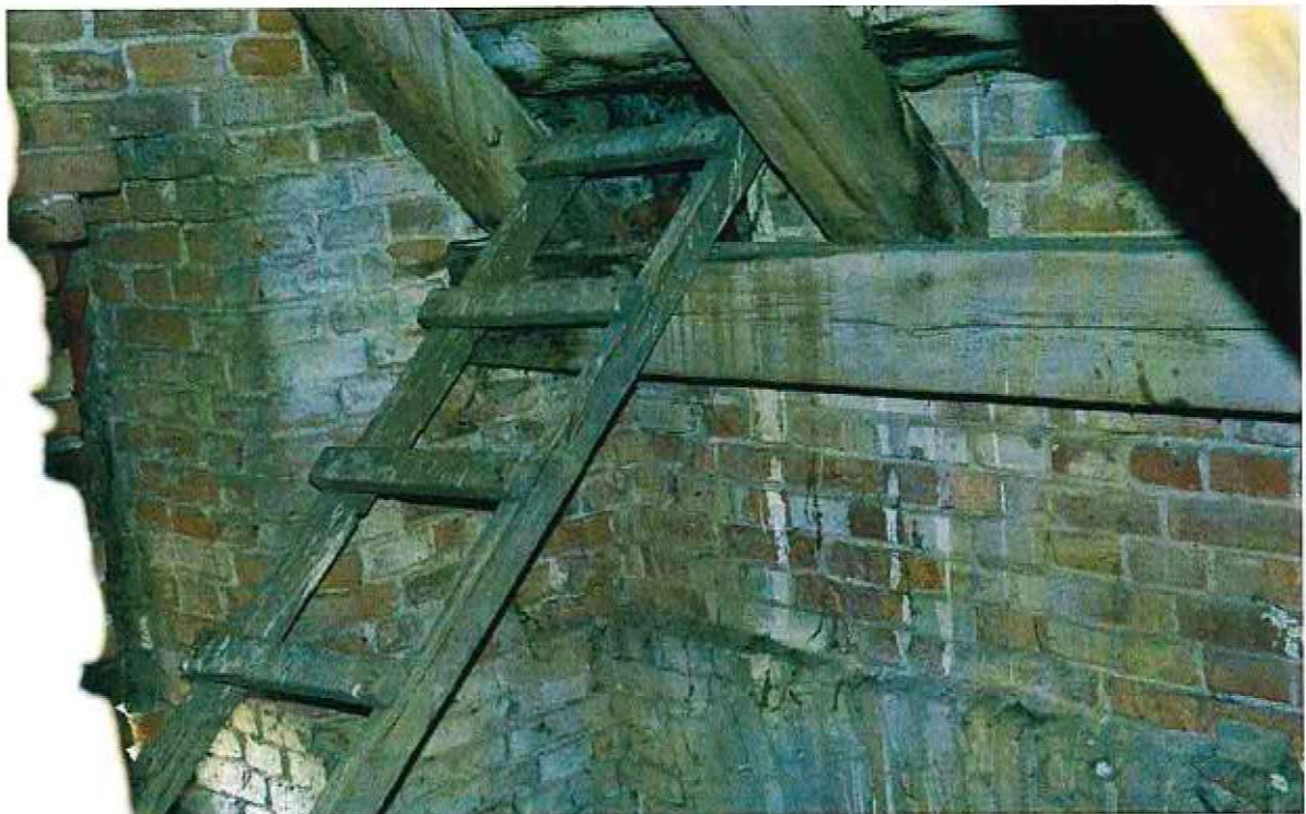
20. Uszkodzenie murlat przy chórze.
