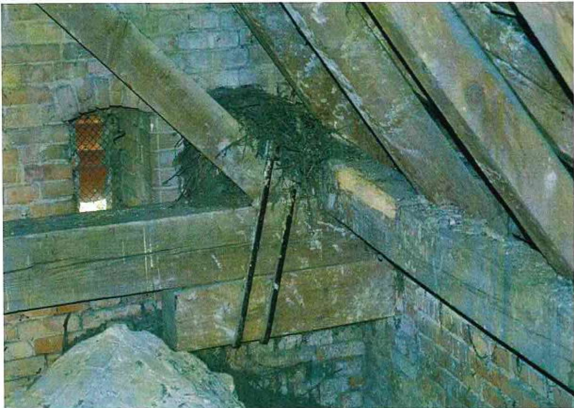
18. Uszkodzenie murłat.
