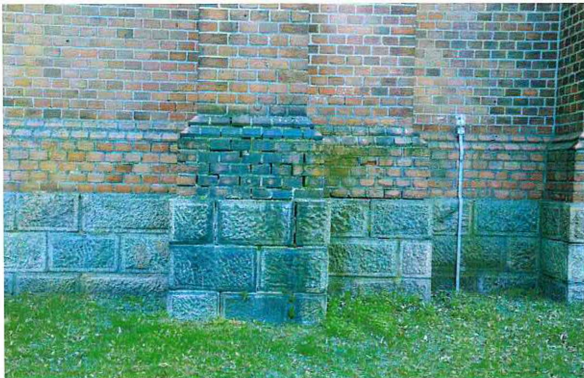
11. Uszkodzenia muru przypór i cokółu.
