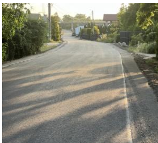
4) Remont drogi w Grudzkowoli 550 mb
