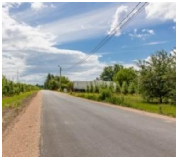
3) Remontu drogi w miejscowości Załęż 1350 mb
