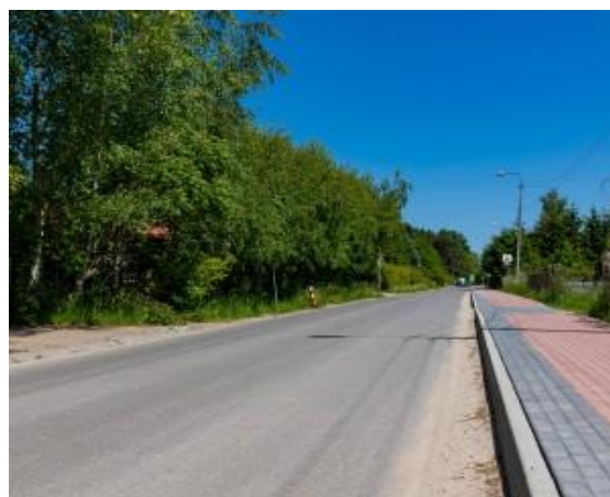
6) Przebudowa ul. Słonecznej w Lesznawoli 1300 mb,
