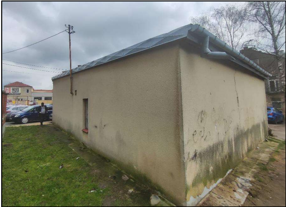
Fot 03 – Naroże elewacji północnej oraz zachodniej
