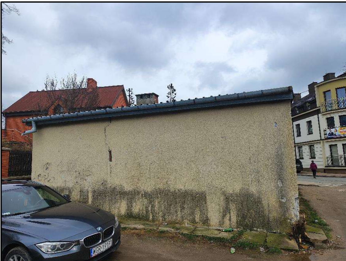
Fot 02 – Elewacja zachodnia
