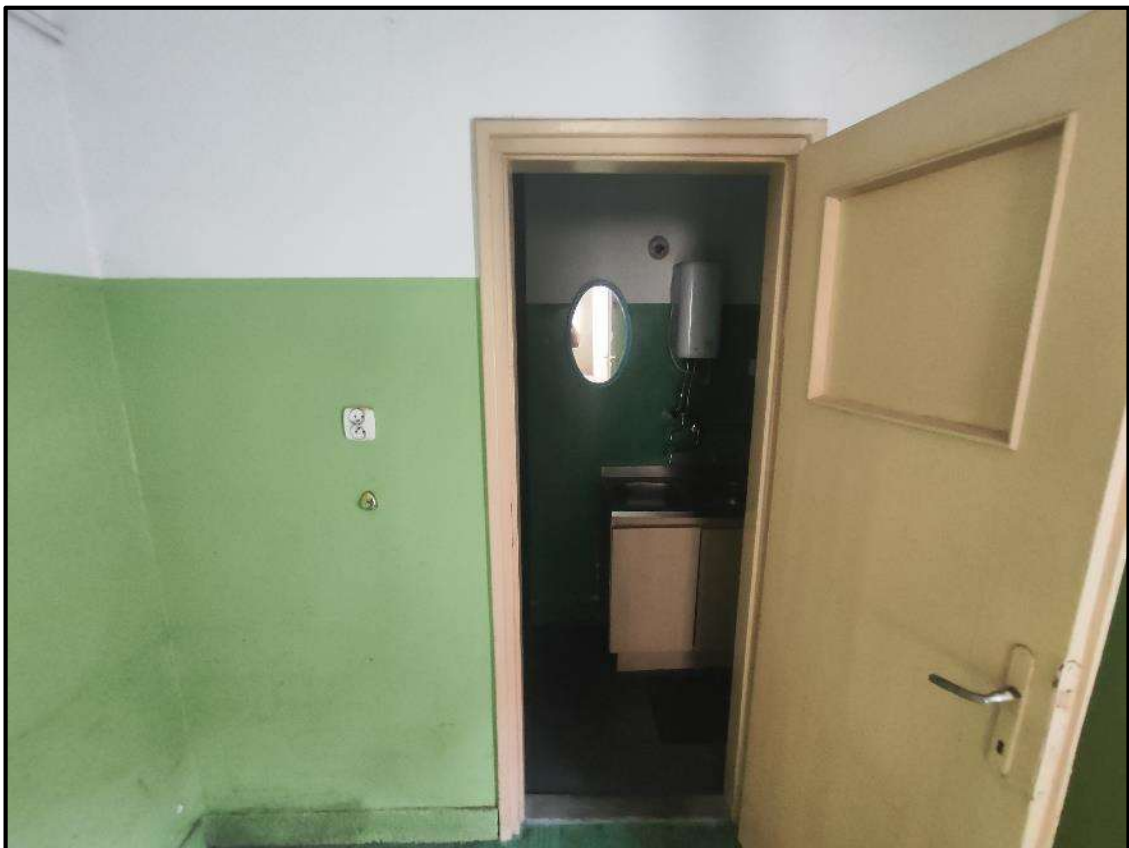
Fot 08 – Wnętrze budynku
