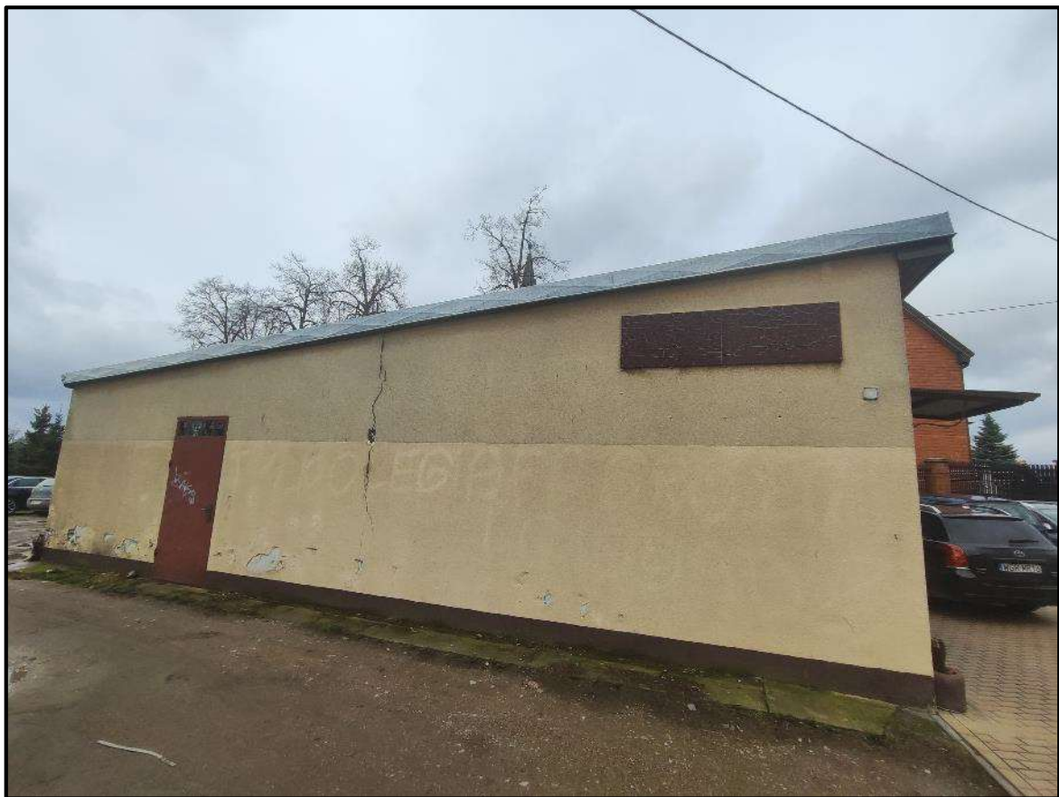
Fot 04 – Elewacja południowa
