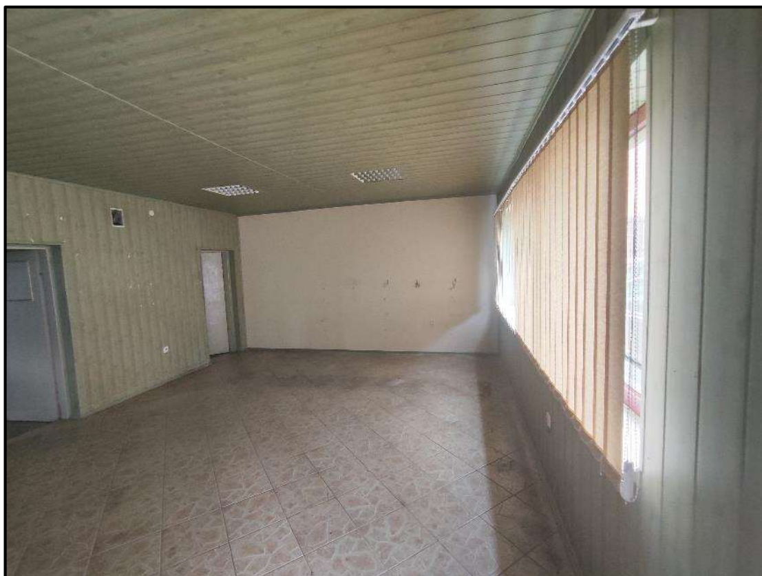
Fot 06 – Wnętrze budynku
