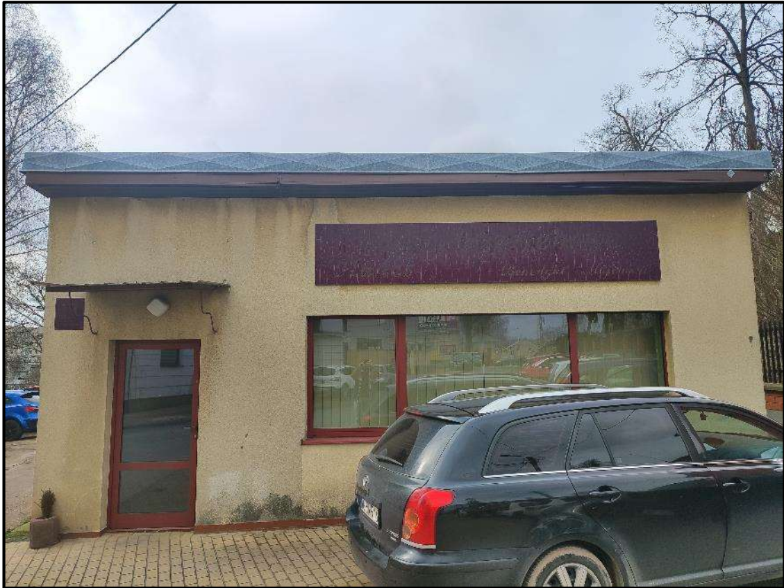
Fot 01 – Elewacja wschodnia (frontowa)
