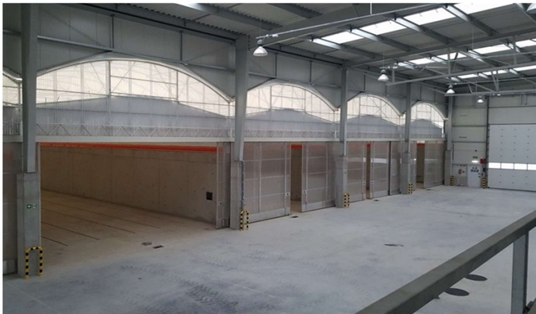
Rysunek 49 Tunele od strony wewnętrznej (hali) - widoczne drzwi przesuwne
