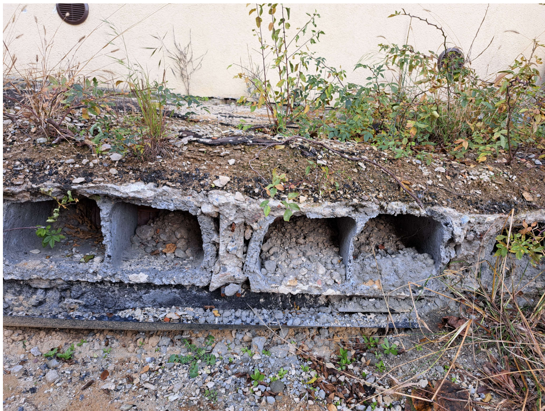
Fot 05 – Piwnica ozn. nr 1. Powierzchnia stropu nad piwnicami.
