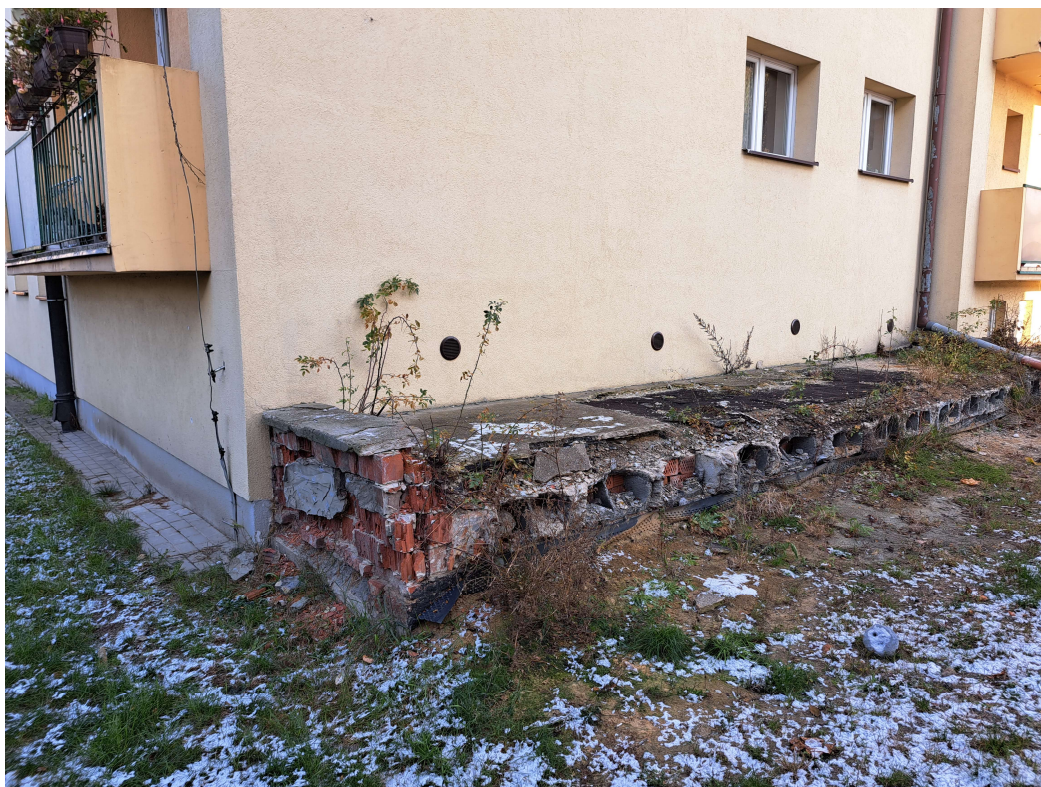
Fot. 02 – Piwnica ozn. nr 1.
