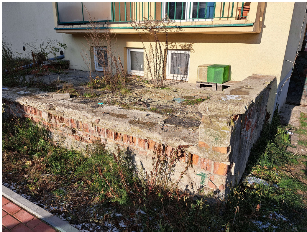
Fot. 01 – piwnica ozn. nr 2
