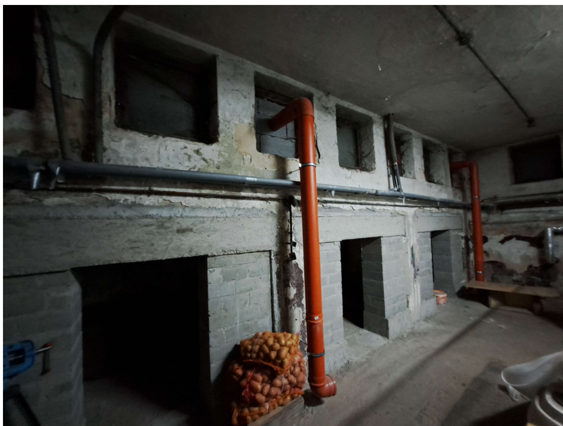
Fot 06 – Piwnica - wewnątrz
