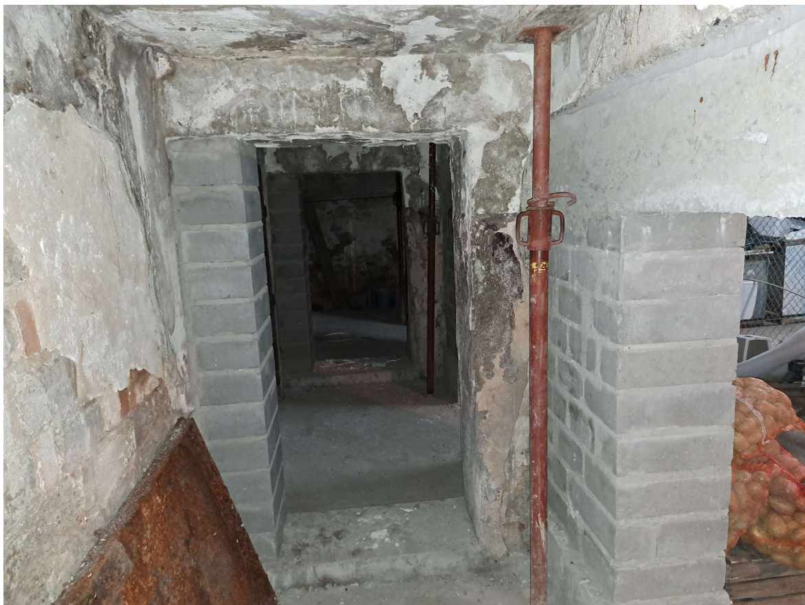
Fot 07 – Piwnica – wnętrze.
