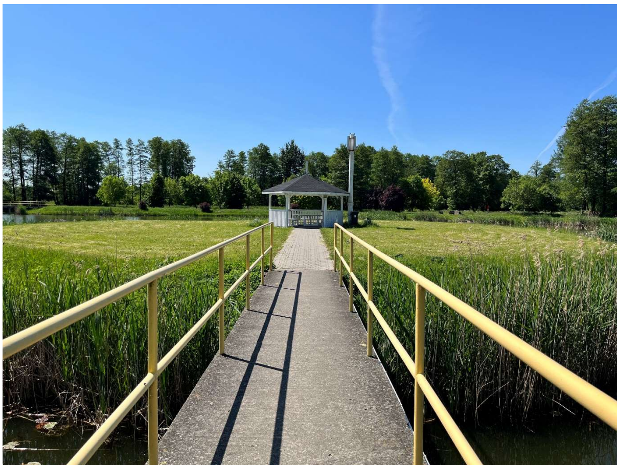
Fot.2.3, Betonowy pomost – uzupełnienia, balustrada – oczyszczenie i malowanie
