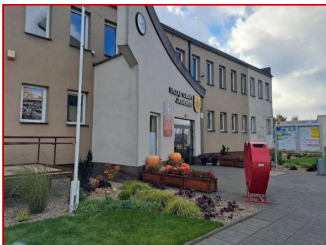
Rysunek 11. Budynek Urzędu Gminy Jasieniec oraz Gminnej Biblioteki Publicznej.
