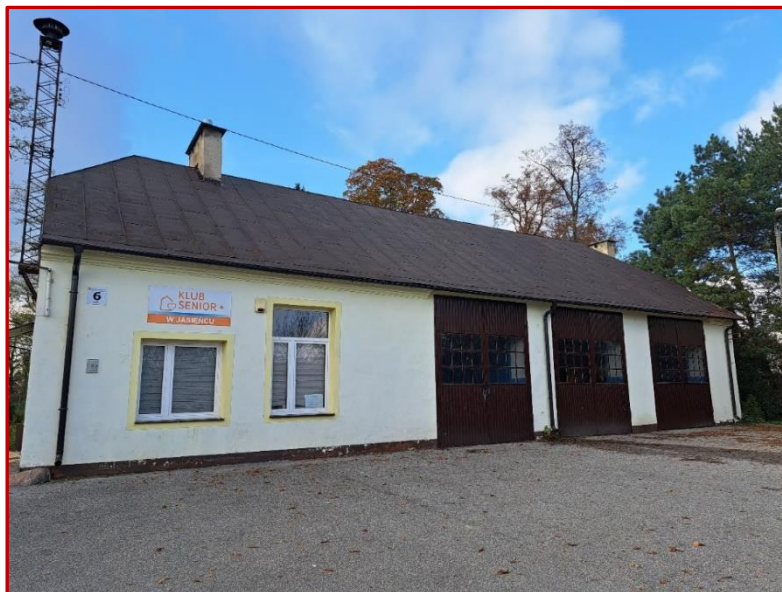
Rysunek 13. Budynek dawnej Strażnicy OSP Jasinieć - obecnie siedziba Klubu Seniora+ oraz magazyn
