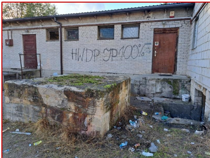
Rysunek 8. Przykłady aktów wandalizmu na obszarze rewitalizacji: graffiti na budynkach przy ul. Czerskiej 2, w pobliżu Urzędu Gminy Jasieniec.
