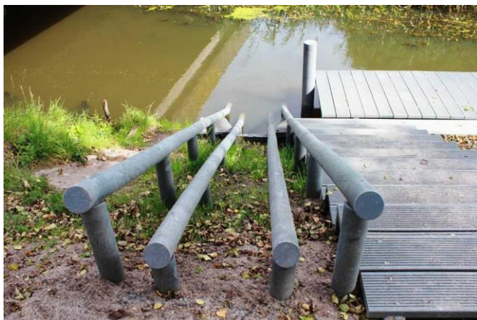
Stylizacja infrastruktury do ślipowania rowerów wodnych
