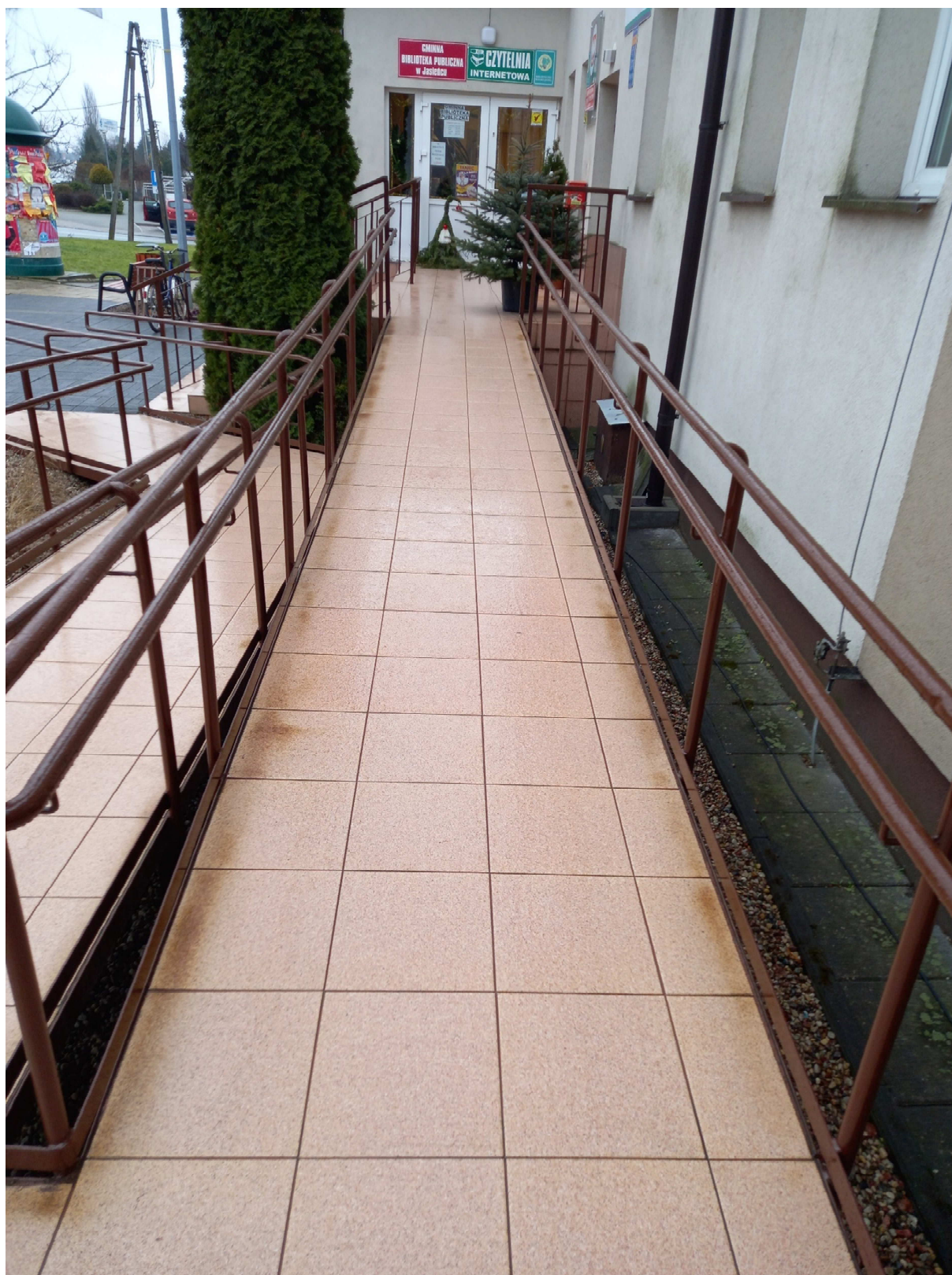
Fot.9 Pochylnia dla niepełnosprawnych
