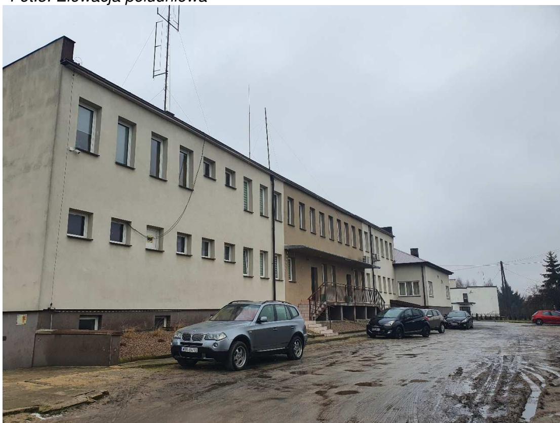
Fot.4. Elewacja południowa
