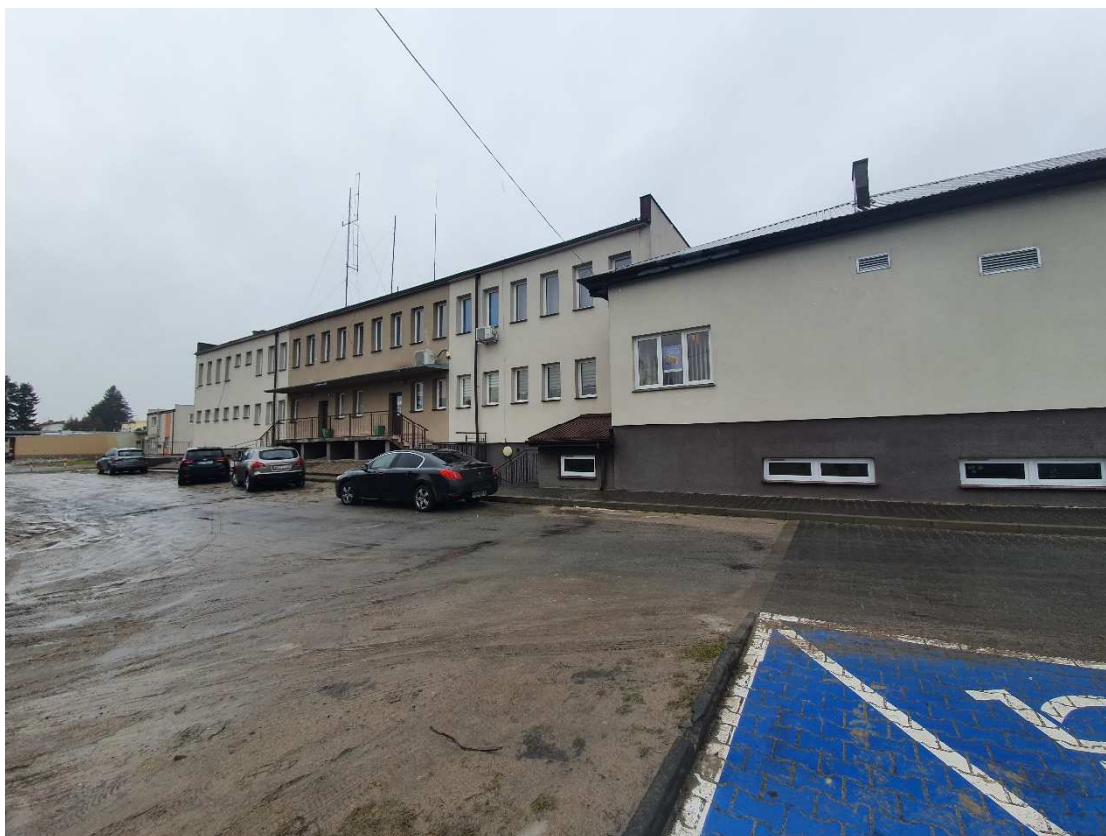
Fot.3. Elewacja południowa
