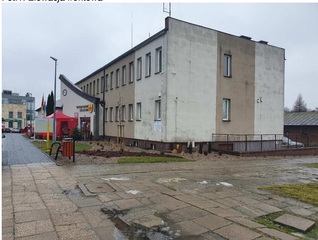
Fot.2. Elewacja zachodnia
