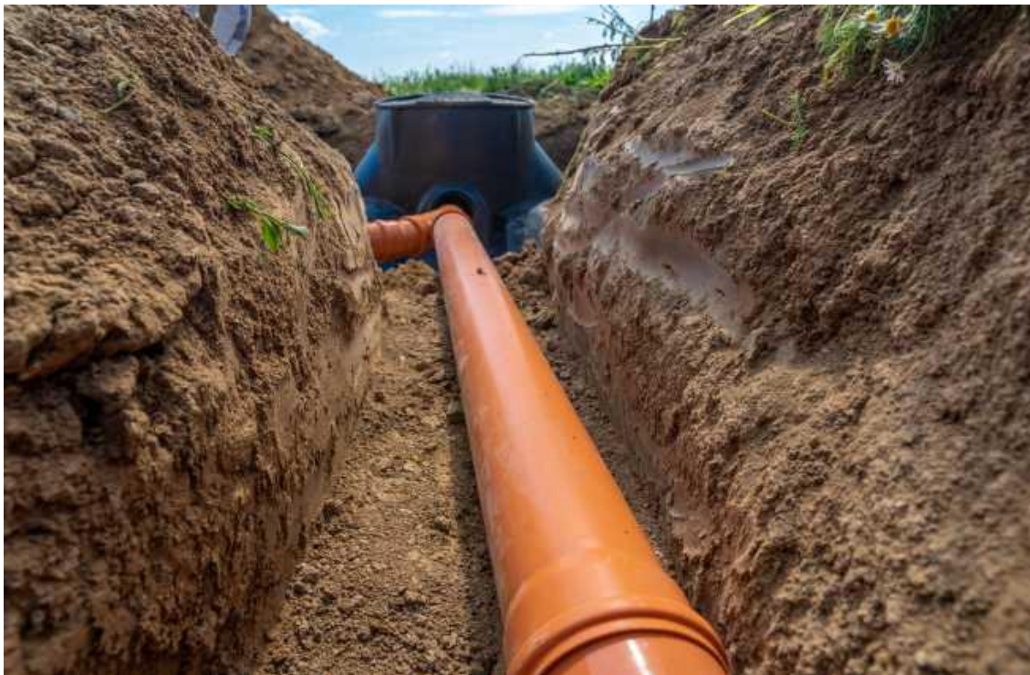
Zdjęcie 13: Fragment budowanej kanalizacji. Źródło: materiały własne.
