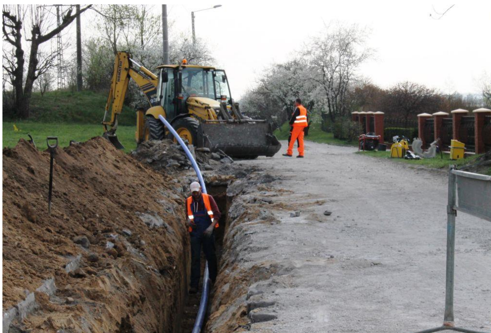
Zdjęcie 8: Roboty budowlane. Źródło: materiały własne.
