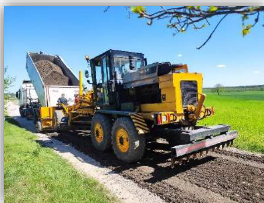
Remont drogi gruntowej w m. Jankowice
