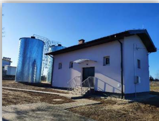
Przebudowany SUW w Jeżowie
