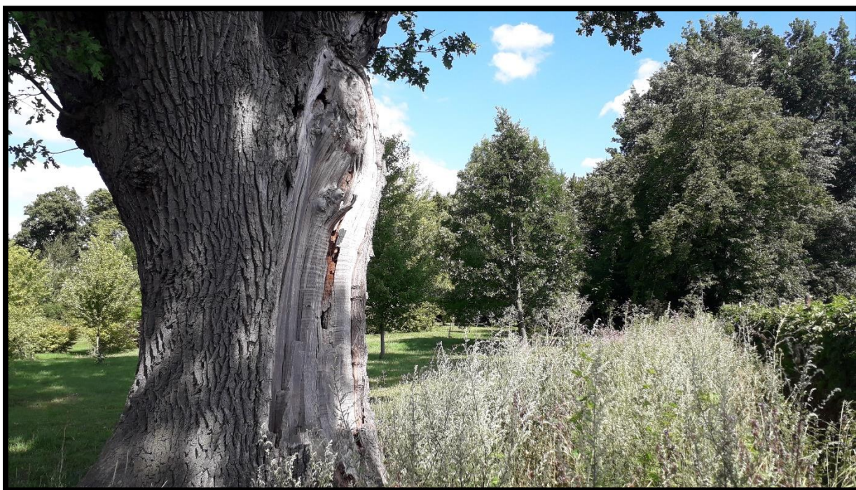
Fot. 12. Ślad po odłamany przewodniku
