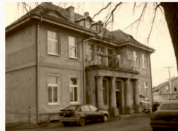
Dwór w Niewieścinie, autor zdjęcia: Marek Kujawa, 2009 r.
