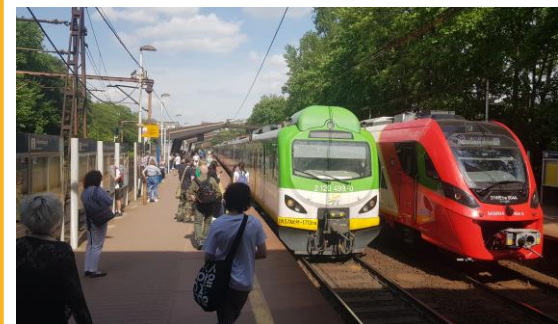
Rys. 2.7 Infrastruktura kolejowa PKP Powiśle w Warszawie
