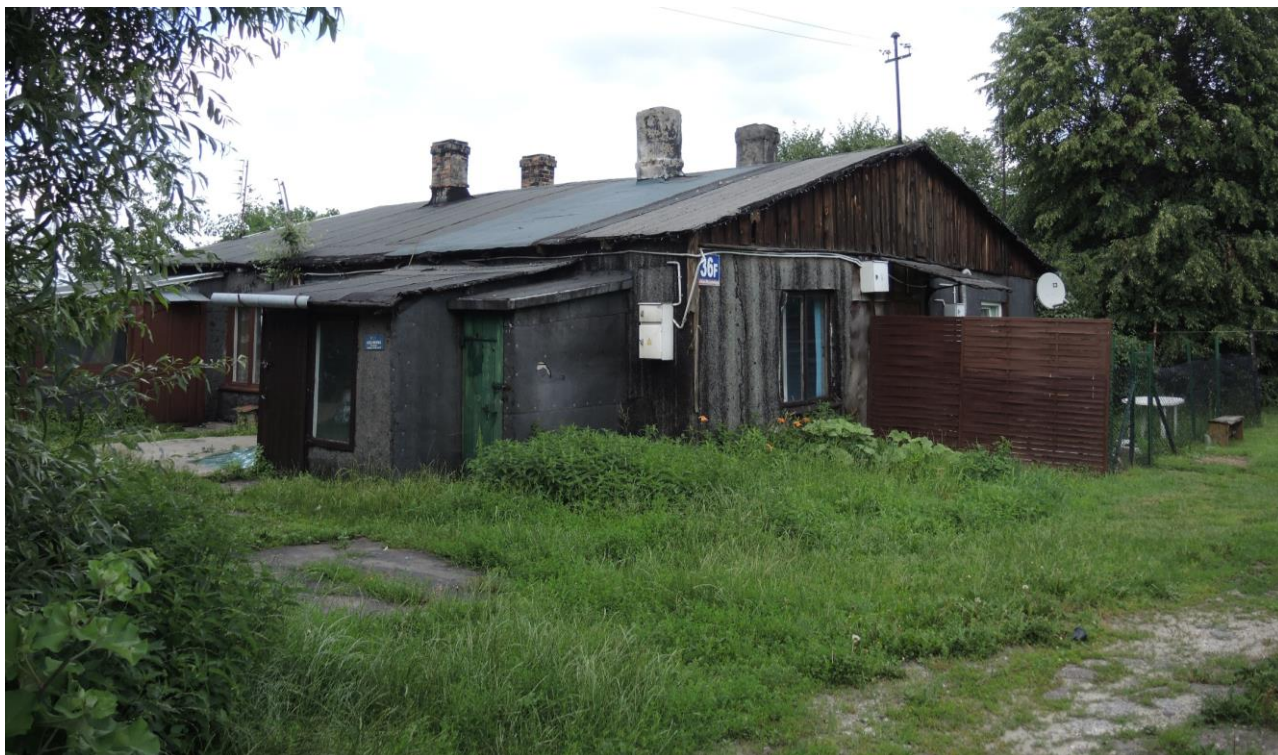
Fot. 5. Substandardowa zabudowa mieszkalna w Górze Kalwarii, rejon ul. Kard. Wyszyńskiego, [autor: J. Kamiński]
