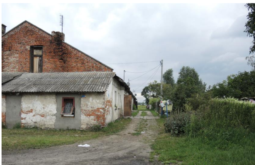
Fot. 9. Zdegradowana zabudowa w Łubnej, w sąsiedztwie składowiska odpadów „Łubna”, będąca skutkiem likwidacji cegielni oraz wieloletniego funkcjonowania składowiska [autor: J. Kamiński]
