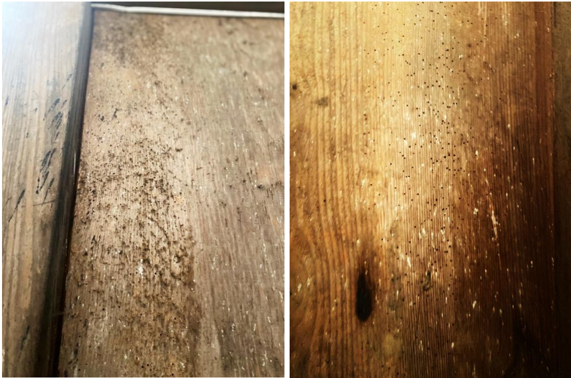
Fot. 5-6 Kościół pw. św. Floriana w Krysku. Ściana tylna ołtarza głównego, widoczne porażenia deskowania przez owady z rodziny kołatkowatych.
