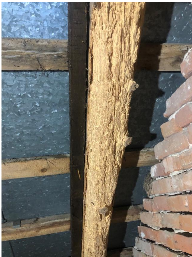
Fot. 23-26 Kościół pw. św. Floriana w Krysku. Widok szczegółowy porażonej więźby dachowej. Widoczne znaczne porażenia przez owady z rodziny kózkowatych.
