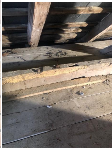
Fot. 23-26 Kościół pw. św. Floriana w Krysku. Widok szczegółowy porażonej więźby dachowej. Widoczne znaczne porażenia przez owady z rodziny kózkowatych.
