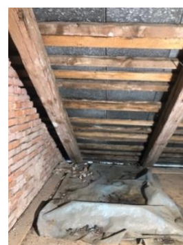
Fot. 13-14 Kościół pw. św. Floriana w Krysku. Widok zacieków i utworów odgrzybiczych na belkach konstrukcji. Fot 14a i b, widoczne zacieki i – plandeka - zabezpieczenie przed zamakaniem do wnętrza kościoła.
