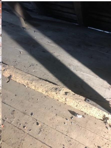
Fot. 19-22 Kościół pw. św. Floriana w Krysku. Widok szczegółowy porażonej więźby dachowej. Widoczne znaczne porażenia przez owady z rodziny kózkowatych i ślady rekonstrukcji.
