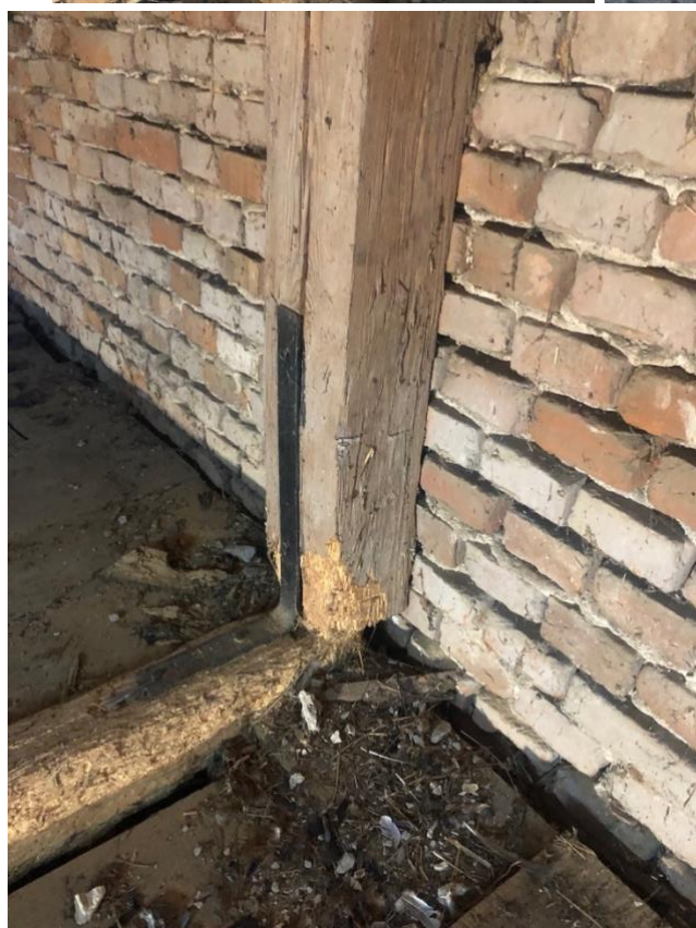
Fot. 27-30 Kościół pw. św. Floriana w Krysku. Widok szczegółowy porażonej więźby dachowej. Widoczne znaczne porażenia połączeń ciesielskich przez owady z rodziny kózkowatych.
