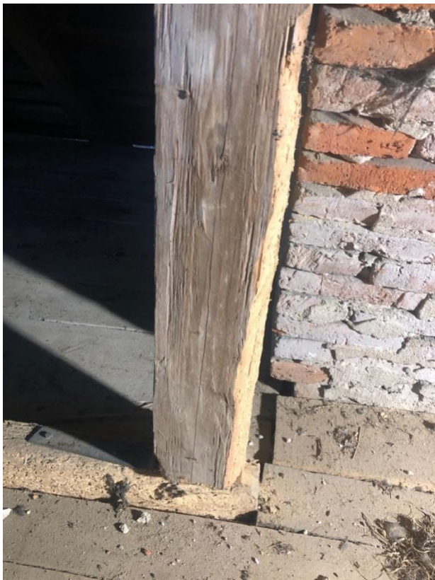
Fot. 19-22 Kościół pw. św. Floriana w Krysku. Widok szczegółowy porażonej więźby dachowej. Widoczne znaczne porażenia przez owady z rodziny kózkowatych i ślady rekonstrukcji.
