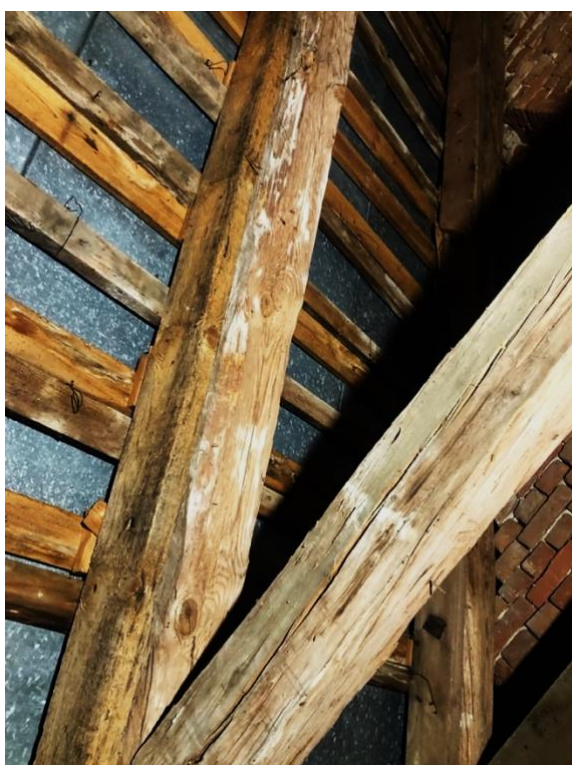
Fot. 13-14 Kościół pw. św. Floriana w Krysku. Widok zacieków i utworów odgrzybiczych na belkach konstrukcji. Fot 14a i b, widoczne zacieki i – plandeka - zabezpieczenie przed zamakaniem do wnętrza kościoła.
