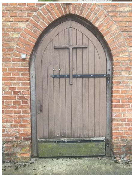
Fot. 38-40 Kościół pw. św. Floriana w Krysku. Przykłady degradacji stolarki - drzwi.
