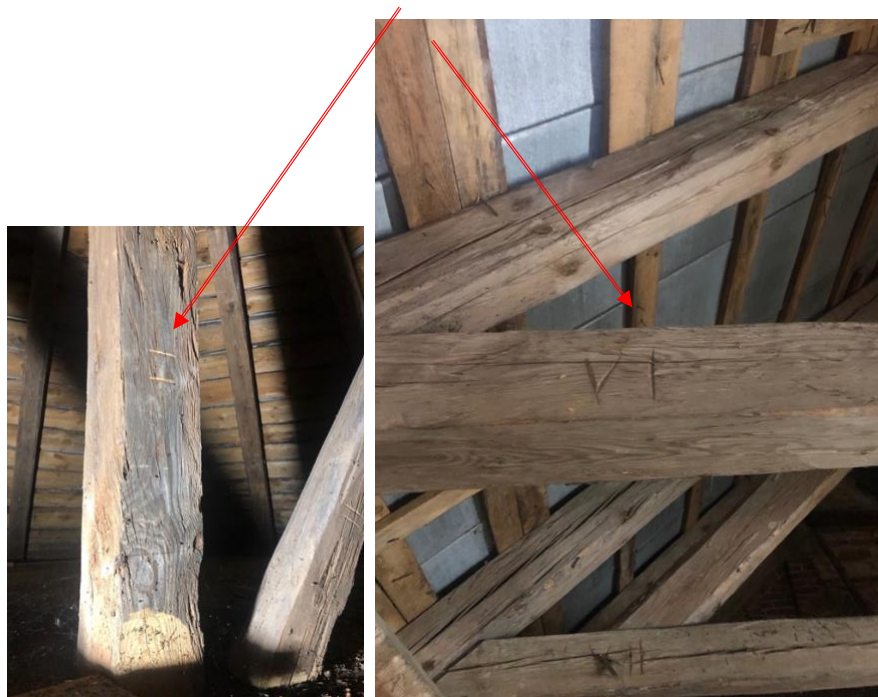
Fot 12 a i b widoczne znaki ciesielskie.
