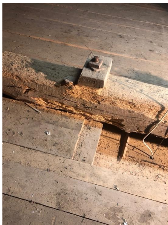
Fot. 27-30 Kościół pw. św. Floriana w Krysku. Widok szczegółowy porażonej więźby dachowej. Widoczne znaczne porażenia połączeń ciesielskich przez owady z rodziny kózkowatych.
