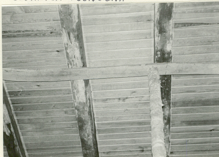
FRAGMENT STROPU BELKOWEGO (Z TYMCZASOWYM ZABEZPIECZENIEM)
