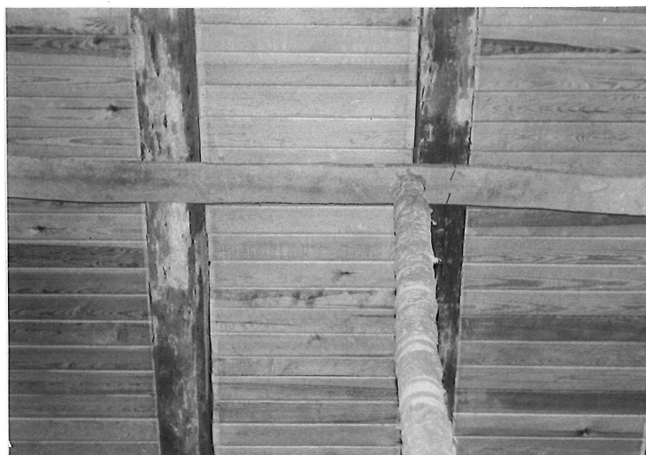
FRAGMENT STROPU BELKOWEGO (z tymczasowym zabezpieczeniem)
