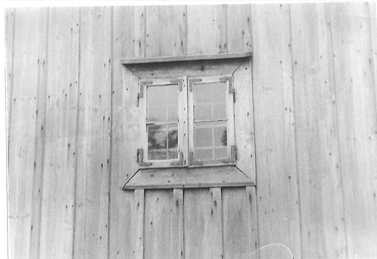
OKNO ELEWACJI WSCHODNIEJ (WIDOK OD ZEWNĄTRZ)
