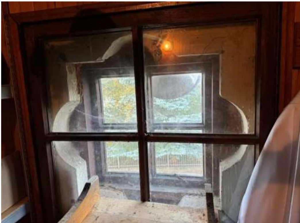
Przykład zarejestrowanej pierwotnej stolarki okiennej w konstrukcji zrębowej kościoła.
