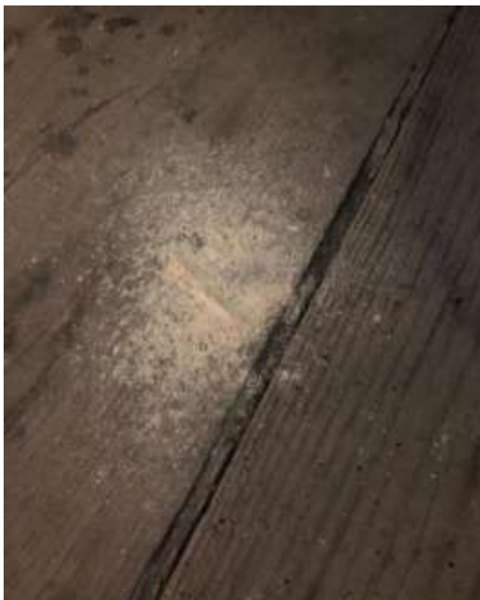
Przykład degradacji drewnianej substancji kościoła przez owady z rodziny kołatkowatych ( Anobidae ) i kózkowatych (Spuszczel Pospolity Hylotrupes Bajulus L.)
