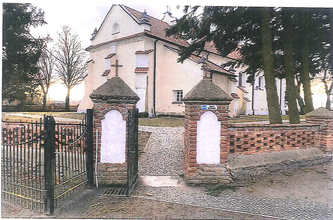
Słupek/kapliczka – wejście boczne od strony Plebani
