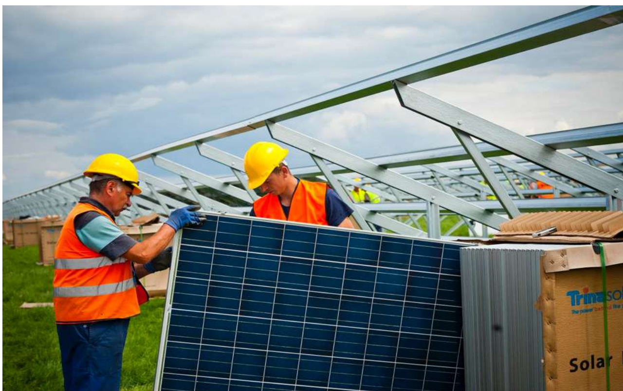
Fot. 3. Montaż konstrukcji stalowych i paneli fotowoltaicznych (źródło: Remor Solar).
