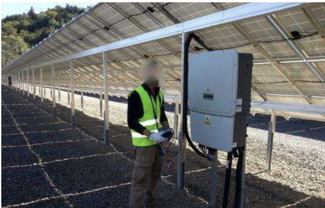
Fot. 5. Instalacja zamontowana pod konstrukcją paneli na pracującej farmie fotowoltaicznej (źródło: www.solgen.pl ).
