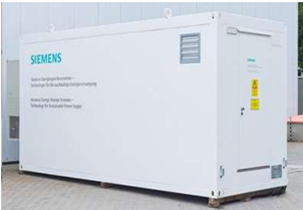
Fot. 8. Kontenerowy magazyn energii, u góry widać uchwyty przeładunkowe (źródło: www.siemens.com ).
