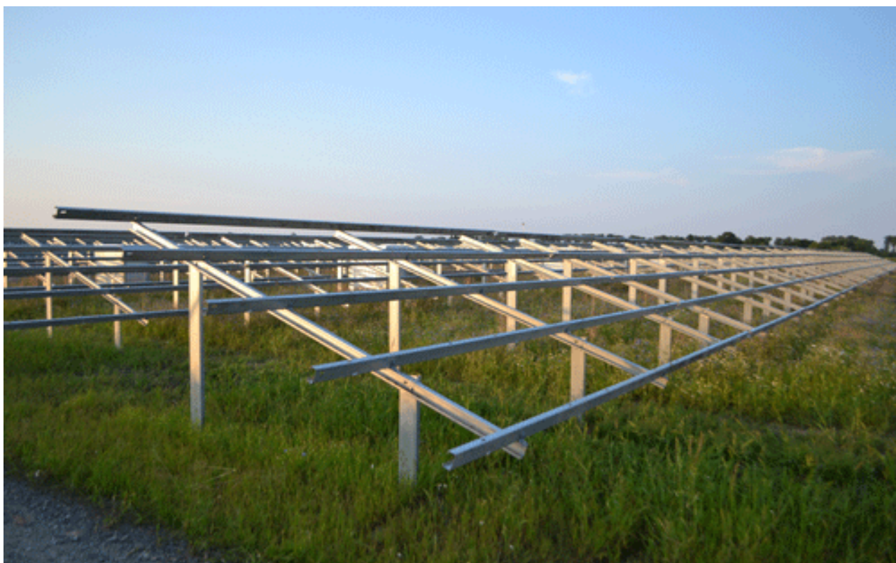
Fot. 2. Stalowa konstrukcja gotowa do montażu paneli fotowoltaicznych (źródło: www.projektsolartechnik.pl ).
