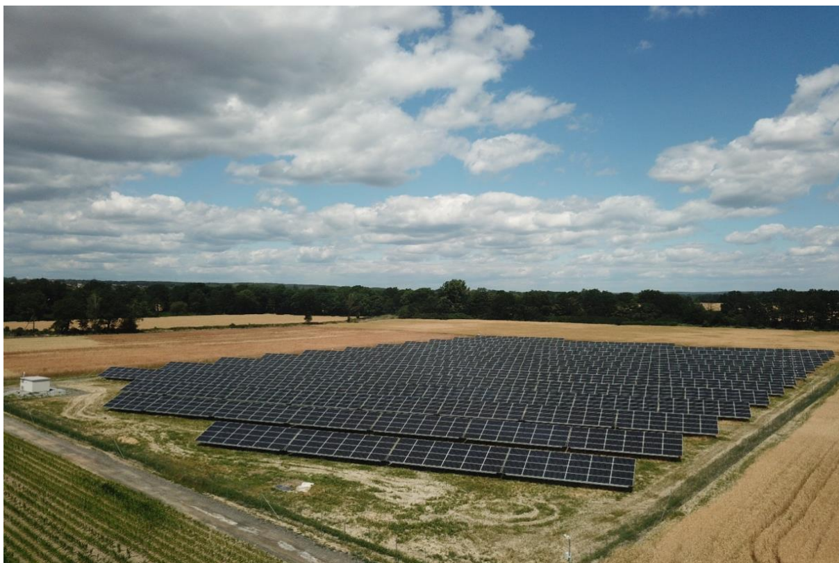
Fot. 1. Przykładowe zagospodarowanie terenu pod oraz pomiędzy rzędami stołów fotowoltaicznych
