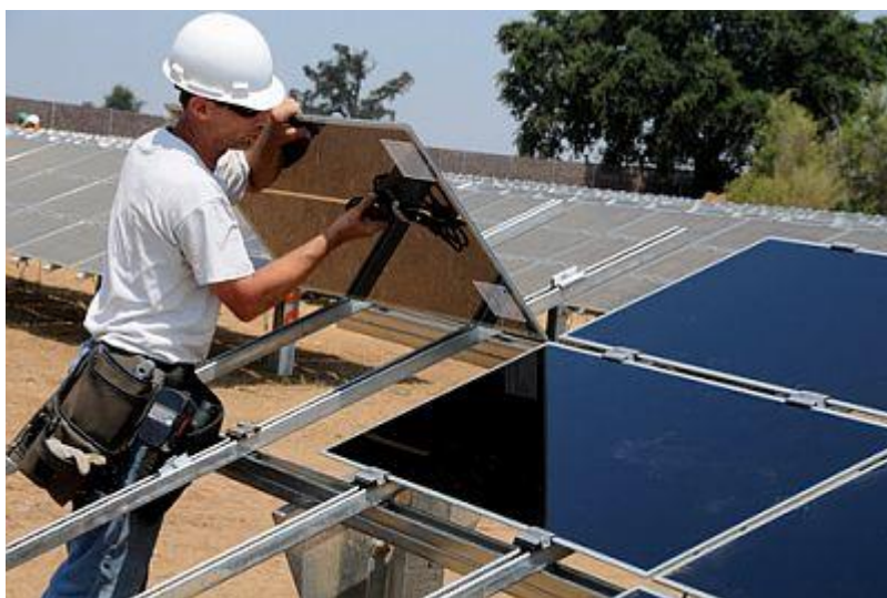
Fot. 3 Montaż modułów na stelażach – przykład
