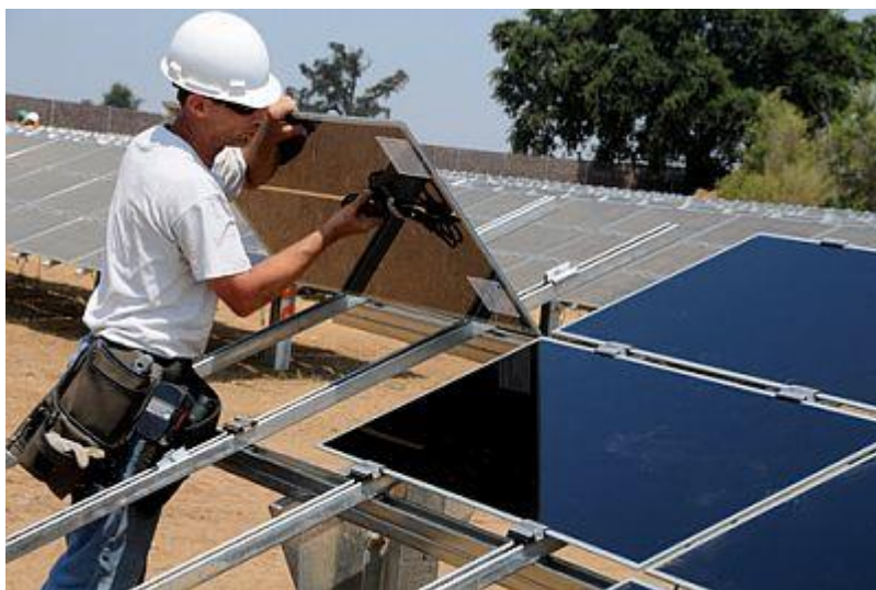
Fot. 3 Montaż modułów na stelażach – przykład
