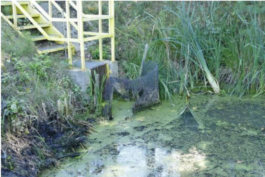
Rysunek 225 Uszkodzona siatka zabezpieczająca, tzw. żabianka
