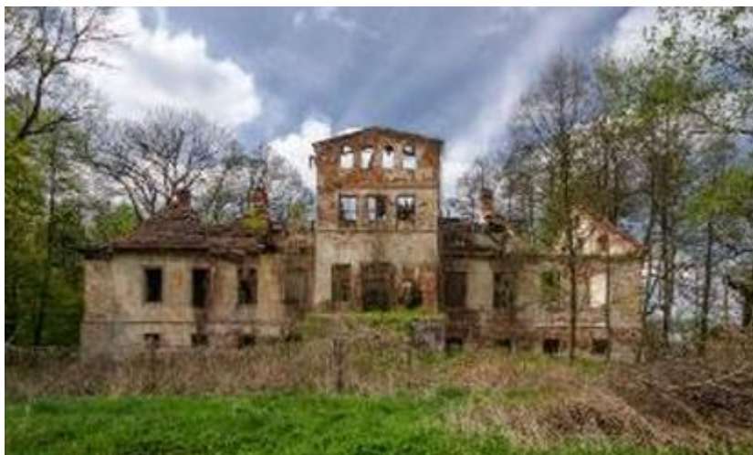
Fotografia 2. Ruiny pałacu w Brodowicach
