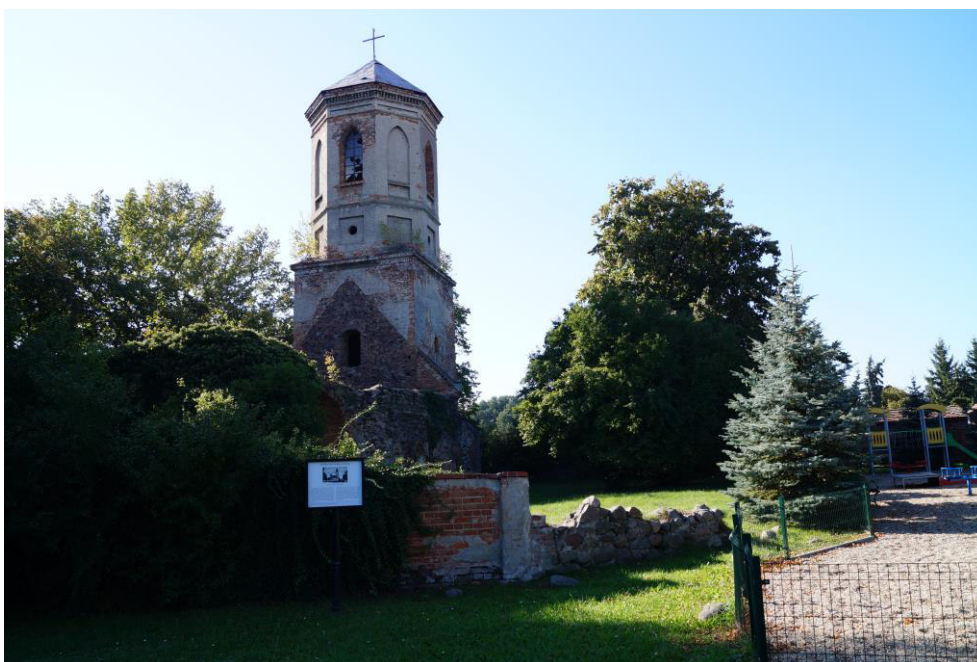
Górzyn, ruina kościoła, stan wrzesień 2025 r.
