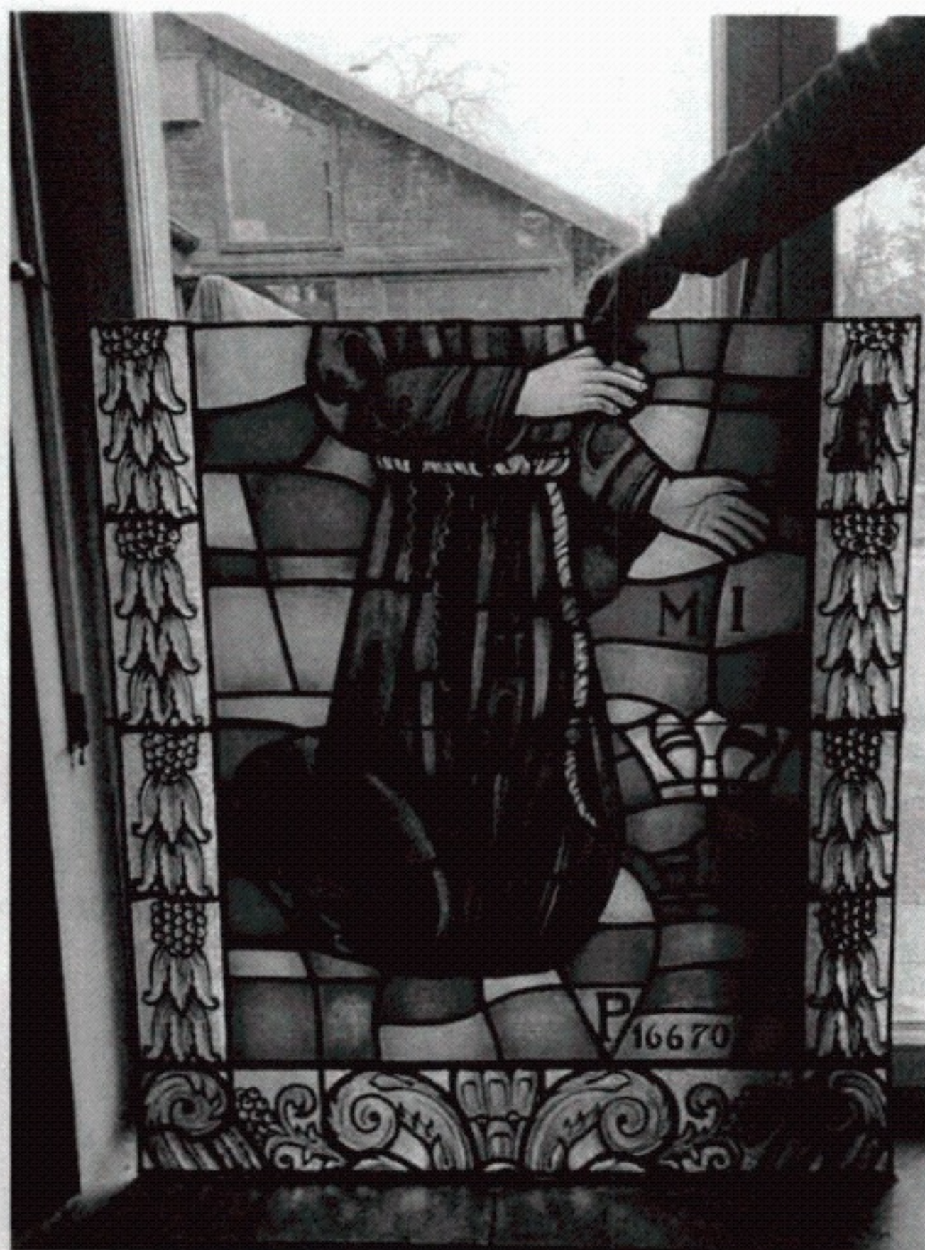
6) a, b, c. Stan kwater witrażowych po zdemontowaniu zniszczonego przez wiatr witraża
