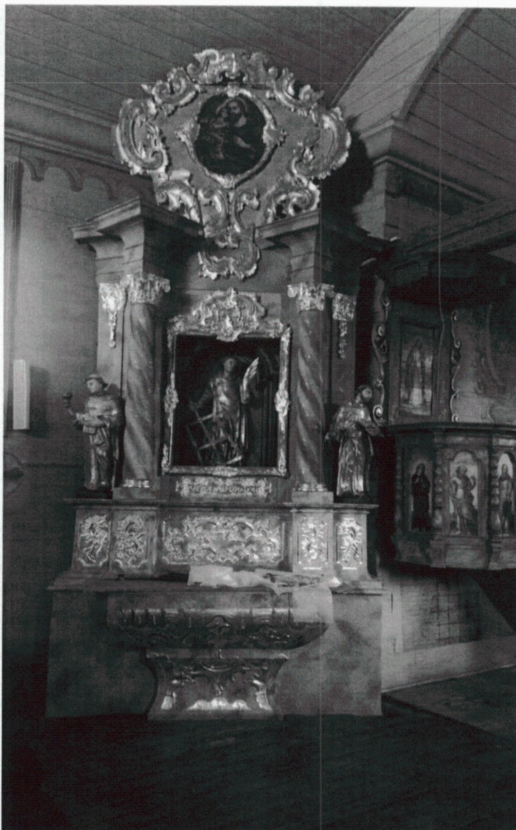
Fot. 2 Kościół pw. Św. Wawrzyńca w Mącznikach. Widok łączenia desek podłogowych nawy i prezbiterium przy ołtarzu bocznym Św. Wawrzyńca po konserwacji w 2018 r. Fot. Ewa Tymcik, 2019 r.
