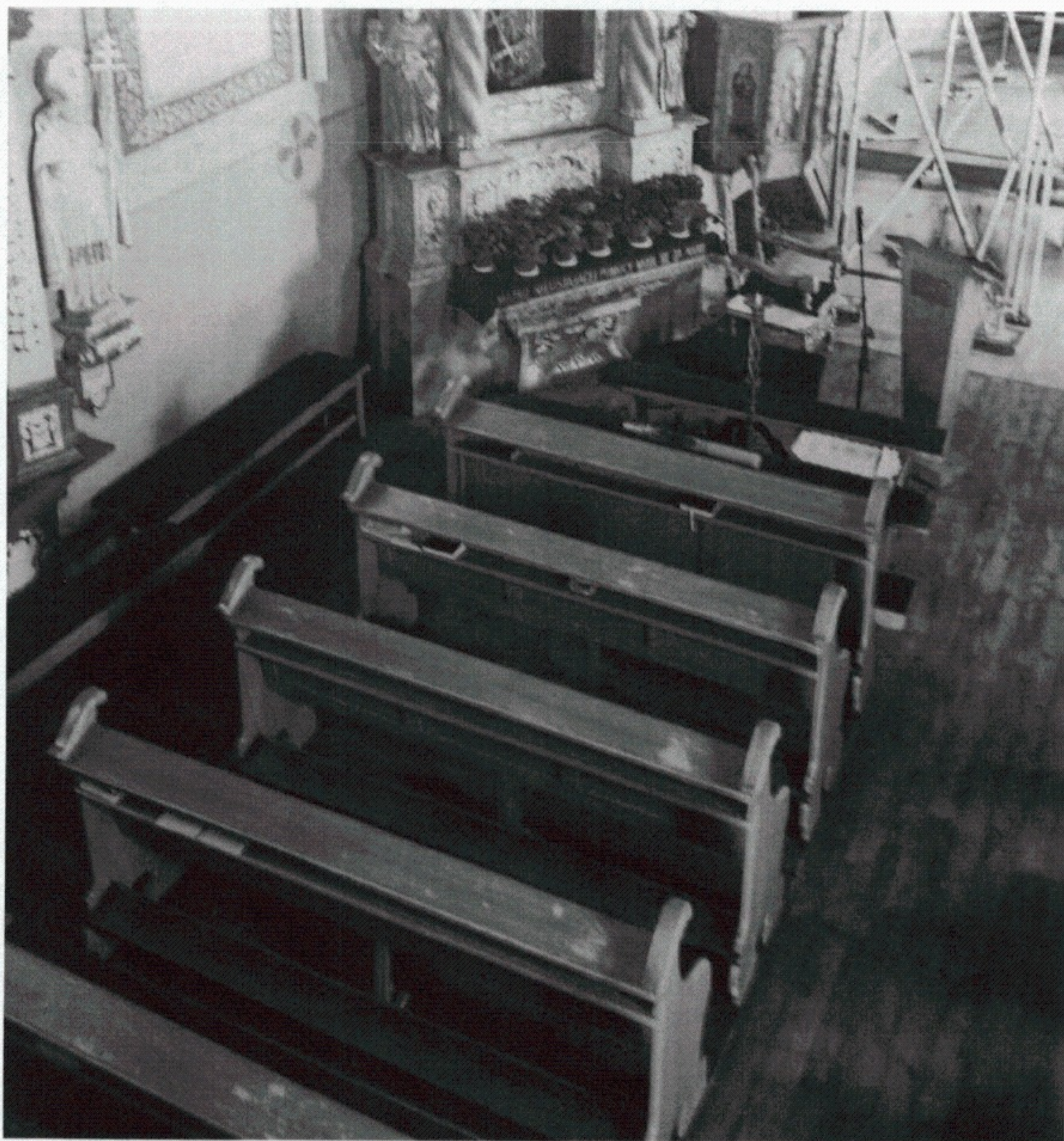
Fot. 3 Kościół pw. Św. Wawrzyńca w Mącznikach. Widok fragmentu pociemniałej i przetartej podłogi z desek sosnowych w nawie. W trakcie prac konserwatorskich w 2019 r. Fot. Ewa Tymcik, 2019 r.
