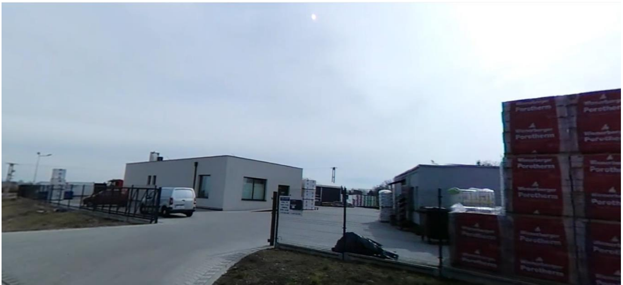
Ryc. 9. Widok na zabudowę przemysłową zlokalizowaną przy skrzyżowaniu drogi prowadzącej do zakładu „MIZGIER” i ul. Brodowskiej
