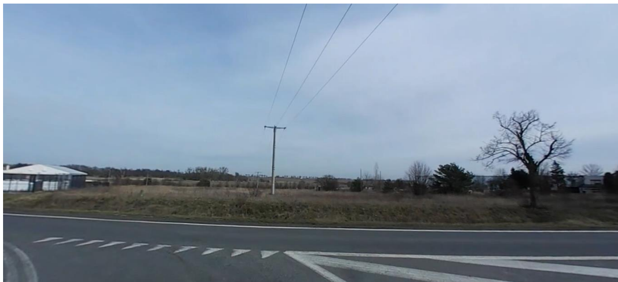
Ryc. 7. Widok na linię średniego napięcia ze skrzyżowania ul. Brodowskiej i drogi krajowej nr 11
