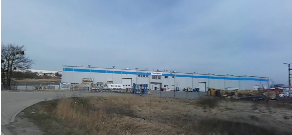
Ryc. 10. Widok na istniejącą zabudowę przemysłową zakładu „Schiessl Polska” przy ul. Brodowskiej
