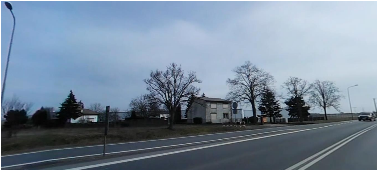
Ryc. 11. Widok na zabudowę mieszkaniową zlokalizowaną przy w centralnej części obszaru opracowania
