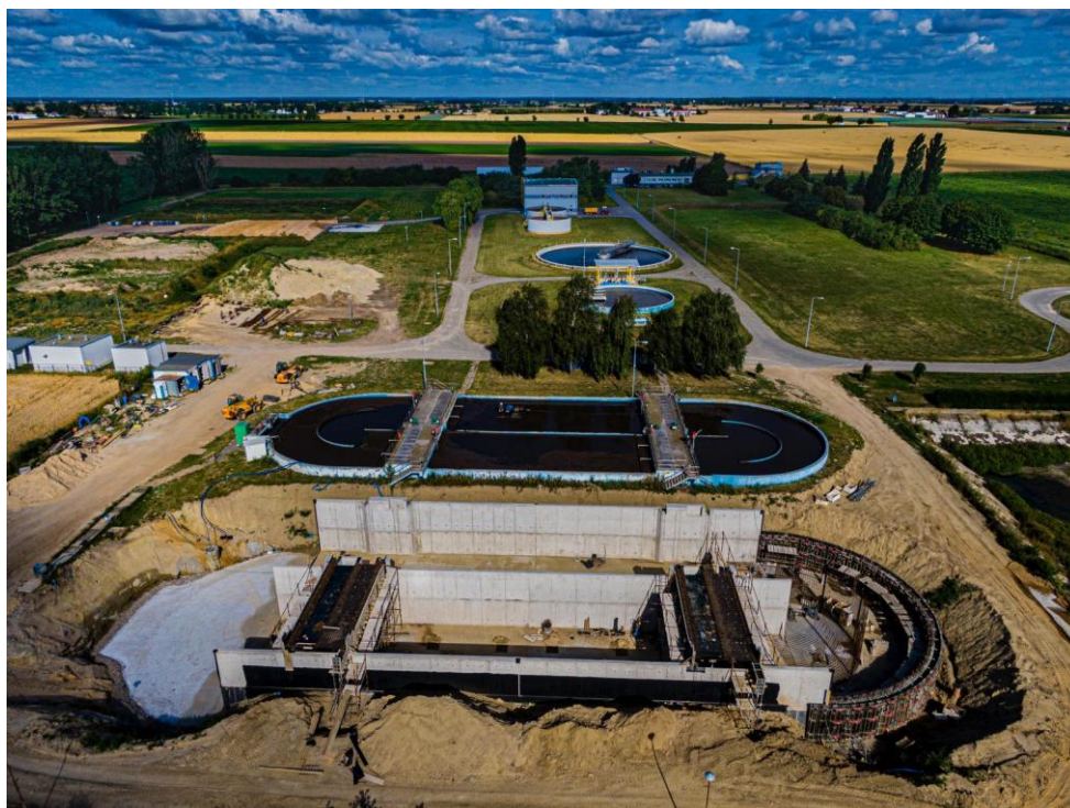
Przebudowa i rozbudowa Oczyszczalni Ścieków w Chwałkowie
