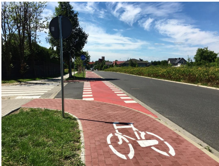
Budowa ścieżek pieszo-rowerowych na ul. Gen. B. Komorowskiego i w Brodowie
