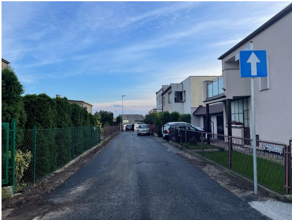
Przebudowa nawierzchni dróg w zakresie ulic Partyzantów, ulicy M. Drzymały, ul. R. Szymańskiego i ul. Miarki w Środzie Wielkopolskiej
