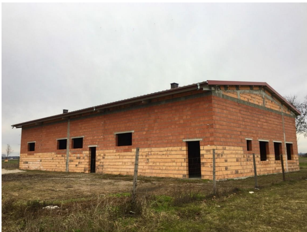
Kontynuacja budowy budynku wielofunkcyjnego w Koszutach
