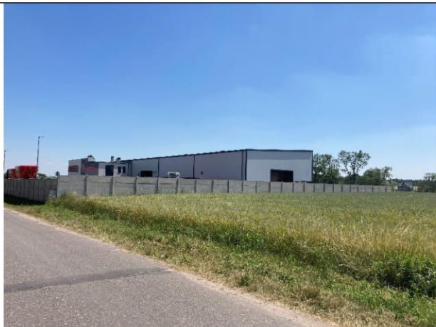
Fot. 1. Zabudowanie sąsiadujące.
