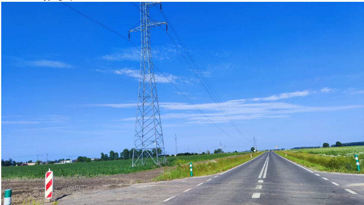
Ryc. 9. Widok na linię elektroenergetyczną wysokiego napięcia, znajdującą się w sąsiedztwie obszaru objętego planem
