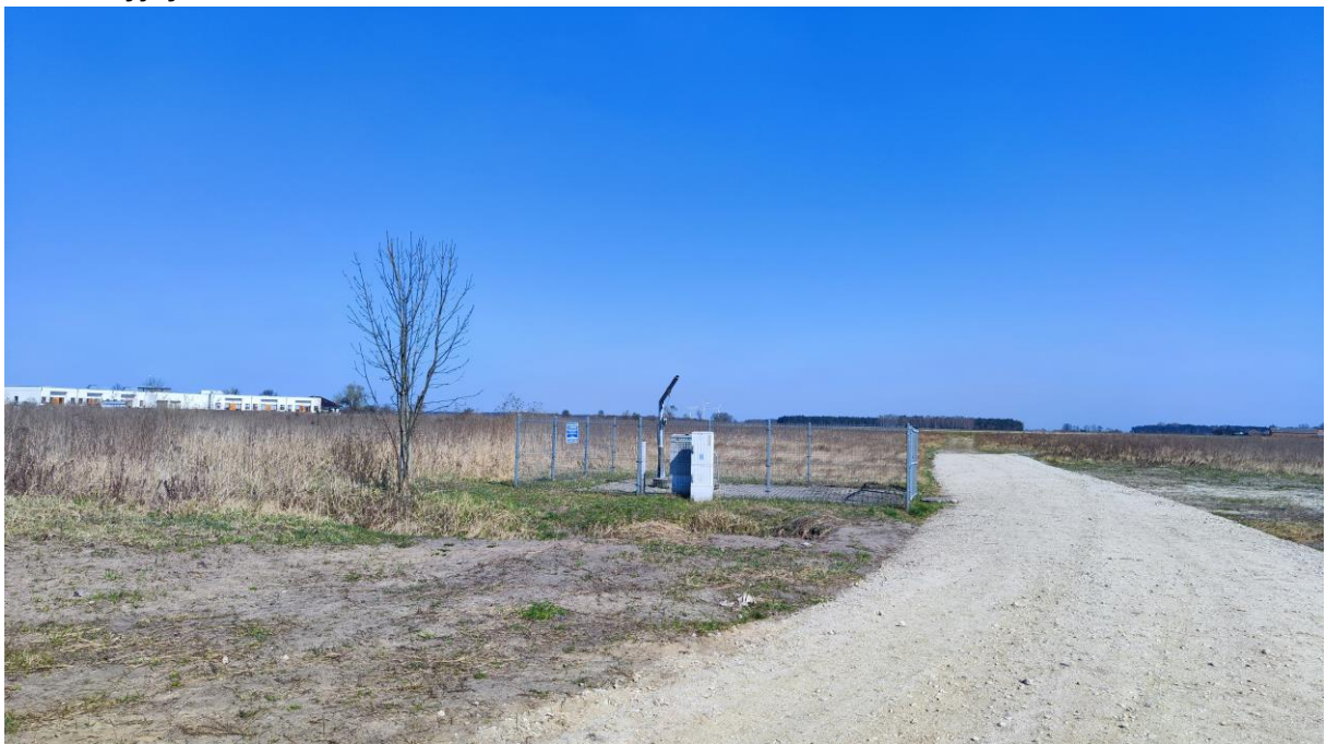
Ryc. 8. Widok na przepompownię ścieków znajdującą się w analizowanym obszarze oraz rów melioracyjny
