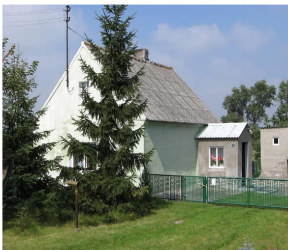
Fot. 15 i 16. Nieuszkodzone płyty azbestowo-cementowe na budynkach w Orzeszkowie i Dominowie – III stopień pilności.
