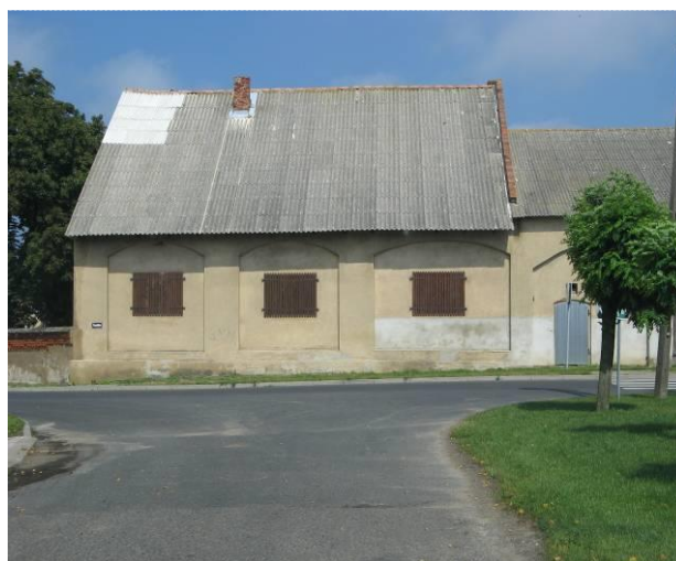
Fot. 15 i 16. Nieuszkodzone płyty azbestowo-cementowe na budynkach w Orzeszkowie i Dominowie – III stopień pilności.
