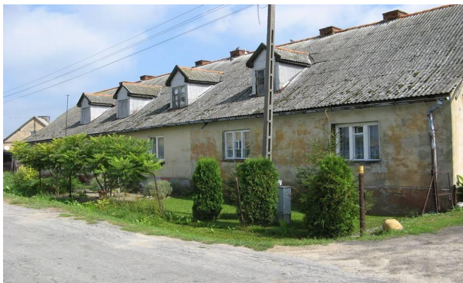
Fot. 14. Płyty azbestowo-cementowe na budynku w Bagrowie – II stopień pilności.
