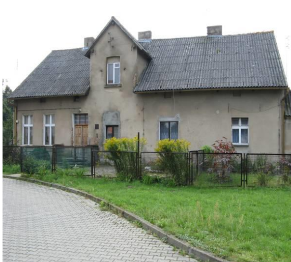
Fot. 3 i 4. Płyty azbestowo-cementowe faliste na budynku mieszkalnym i przemysłowym w Dominowie.
