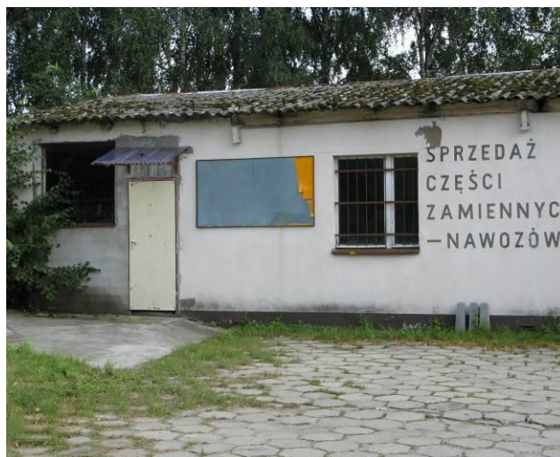
Fot. 3 i 4. Płyty azbestowo-cementowe faliste na budynku mieszkalnym i przemysłowym w Dominowie.
