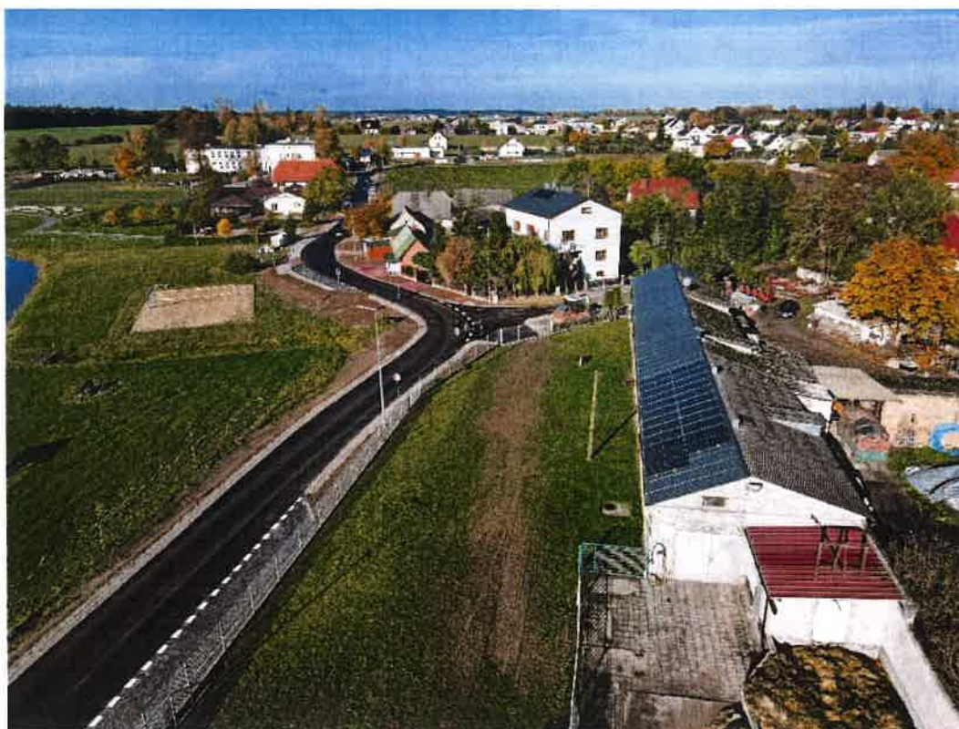
Modernizacja drogi gminnej ul. Szkolna w miejscowości Szczepanowo
