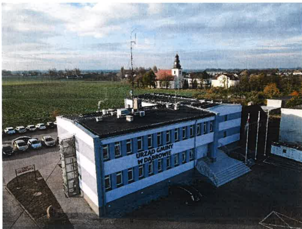
Termomodernizacja Budynku Urzędu Gminy w Dąbrowie
